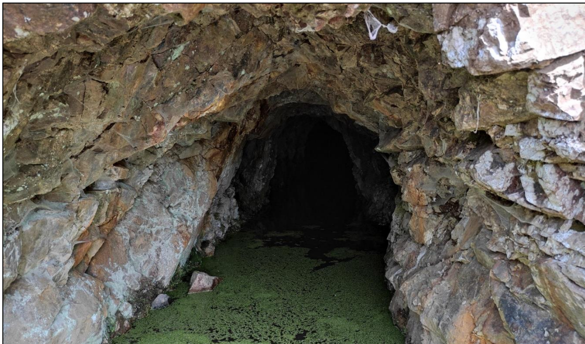
Figura 20 - Galleria n° 4 inferiore.
