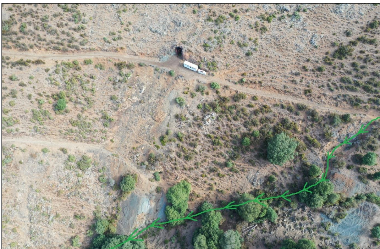
Figura 19 - Solco da ruscellamento concentrato presso il cantiere di Mammoini.
