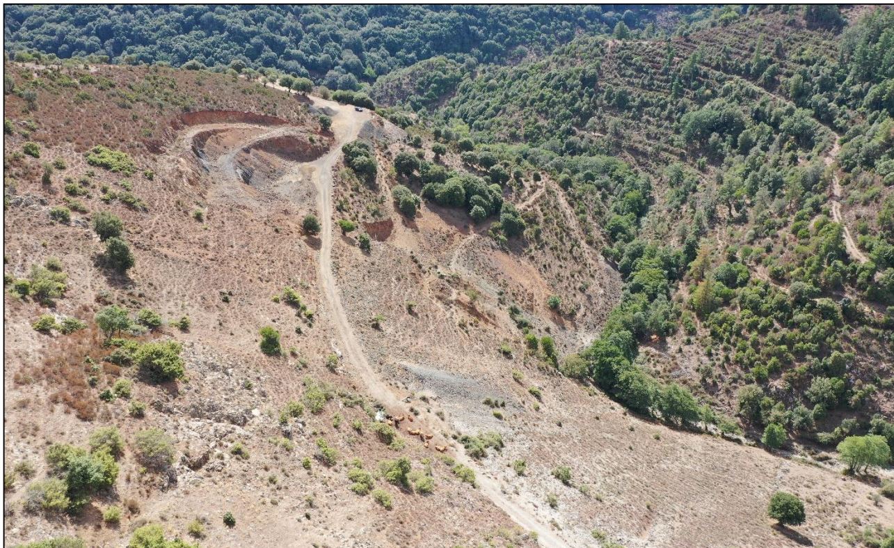
Figura 13 –La valle del Rio Giacurru presso il cantiere di Perdabila bassa.
