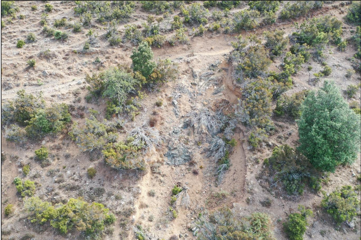
Figura 45 - Solco da ruscellamento concentrato con trasporto di massa presso la Galleria n°6.
