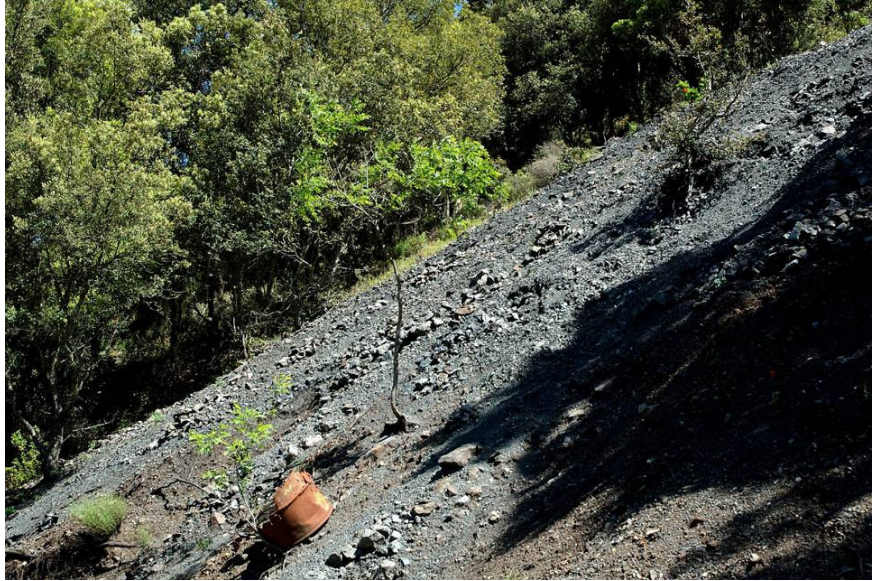
Foto 11. L'opera di ripristino attuata sulle discariche della riva destra del Rio Saraxinus non ha dato i risultati attesi. In questo caso sembra non siano state adottate misure adeguate alla situazione di forte acclività. Da un alto, infatti, mancano idonee strutture di contenimento, dall'altro sono state utilizzate essenze alloctone come Robinia pseudoacacia , che possiede scarse capacità di frenare i processi erosivi.
