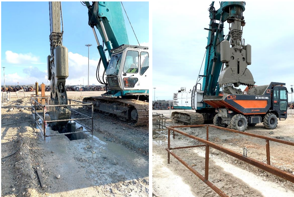
Figura 4. Operazioni di scavo con benna mordente
