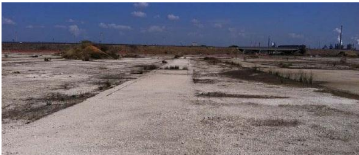
Figura 3.38 – Foto 12, Panoramica piazzali cementati con cemento armato, direzione fotografica NE
