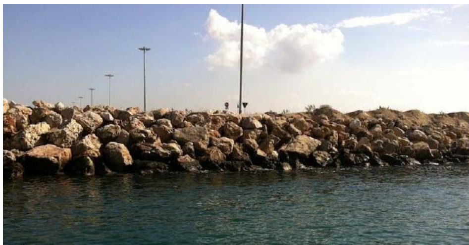
Figura 3.18 – Foto 6, Panoramica scogliera frangiflutto testata 5° sporgente, dir. fotografica SE
