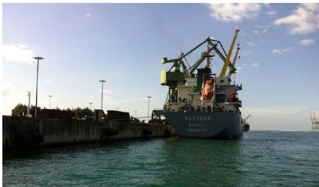
Figura 3.17 – Foto 5, Panoramica banchina 5° sporgente, direzione fotografica SO
