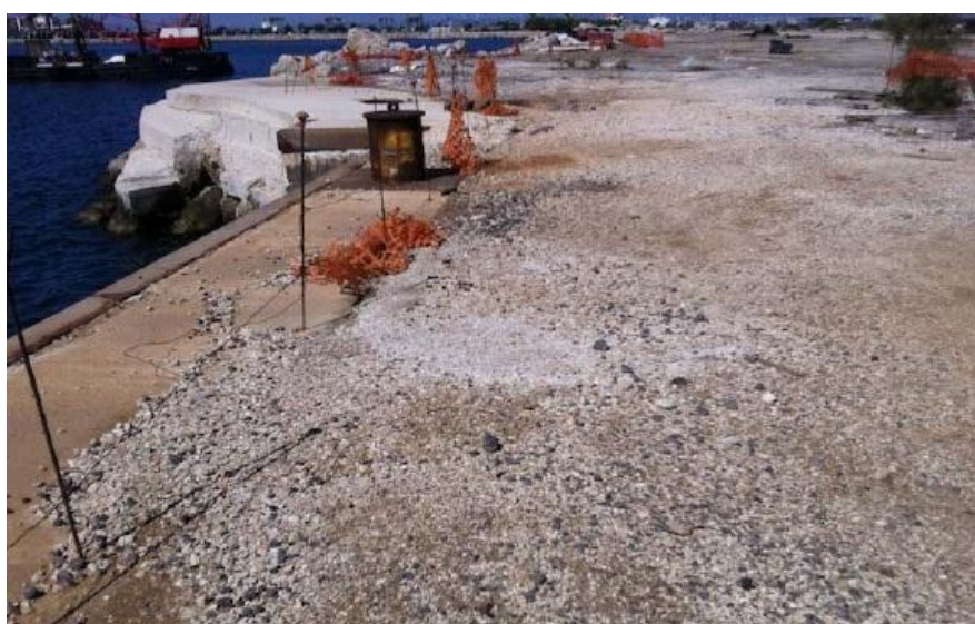
Figura 3.34 – Foto 4, Panoramica area di banchina area Yard Belleli, direzione fotografica NO
