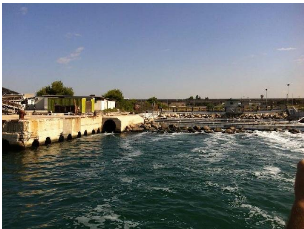
Figura 3.15 – Foto 2, Panoramica canale uscita acque scarichi industriali e civili, direzione fotografica NE
