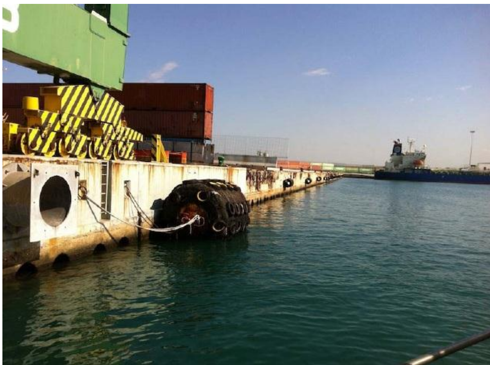
Figura 3.14 - Foto-1, Panoramica banchina di radice del Molo Polisetoriale, direzione fotografica NE
