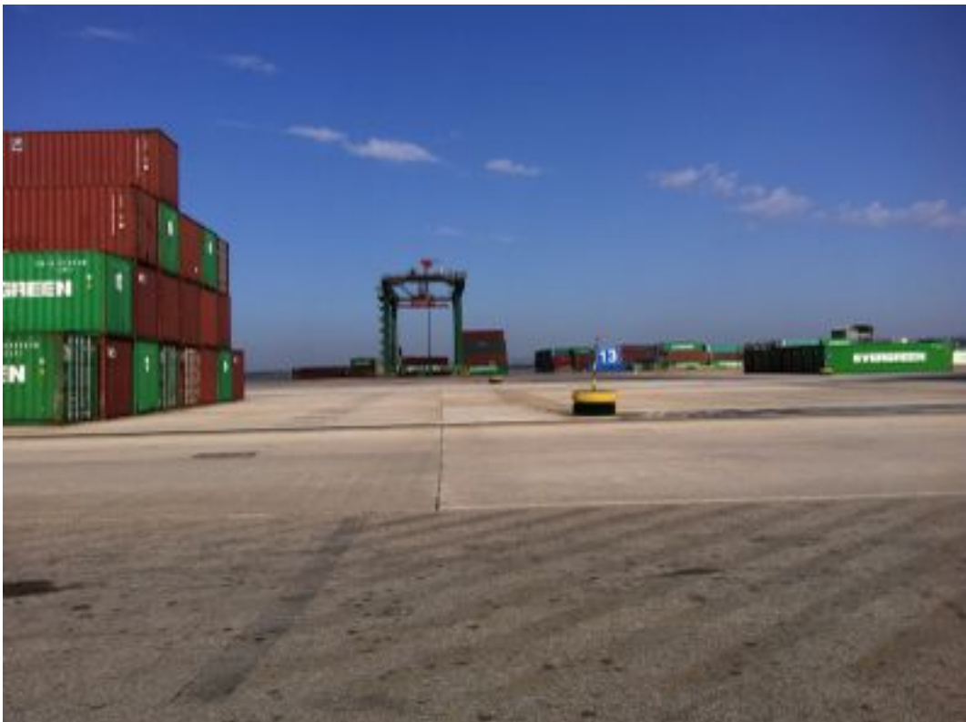
Foto 4. Panoramica piazzale molo polisetoriale porzione centrale, direzione fotografica NO
