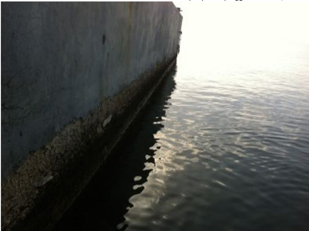
Foto 14. Particolare porzione terminale banchina di attracco navi, dir. fotografica NE
