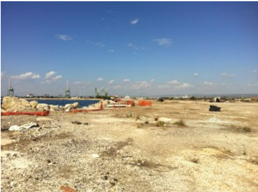
Foto 8. Panoramica piazzali di lavorazione area Yard Belleli, dir. fotografica NO
