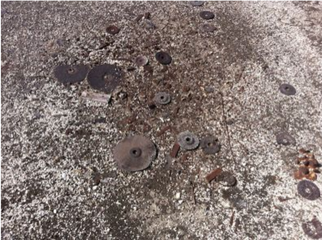
Foto 20. Particolare scarti di lavorazione presenti nel terreno, dir. fot. Nord
