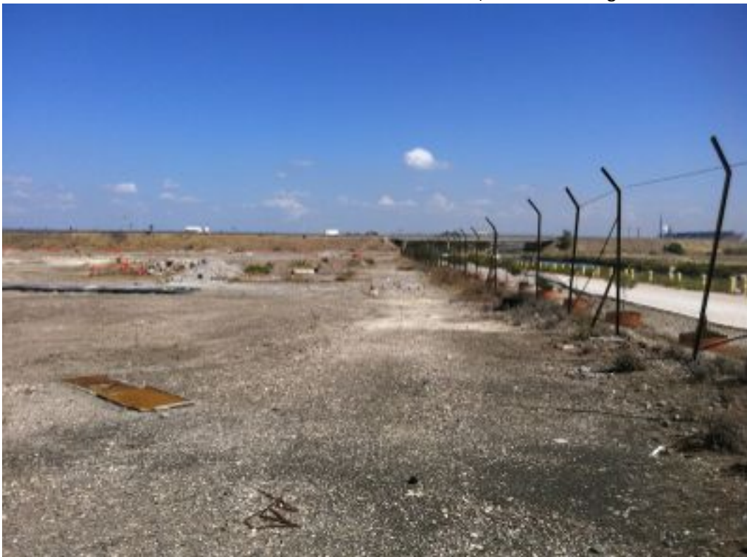
Foto 18. Panoramica recinzione di confine Sud Yard Belleli, dir. fot. NE
