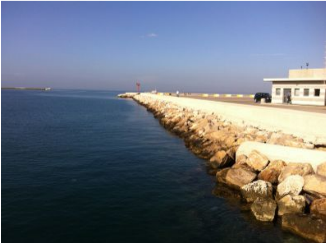
Foto 15. Panoramica frangiflutti porzione terminale del molo polisetoriale, dir. fotografica Ovest
