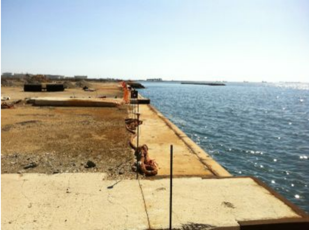
Foto 9. Panoramica banchina in cemento armato, dir. fotografica SE
