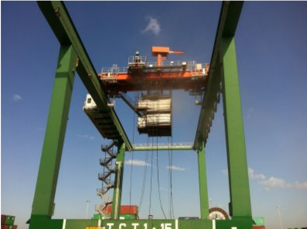
Foto 3. Particolare gru in riparazione, direzione fotografica SO
