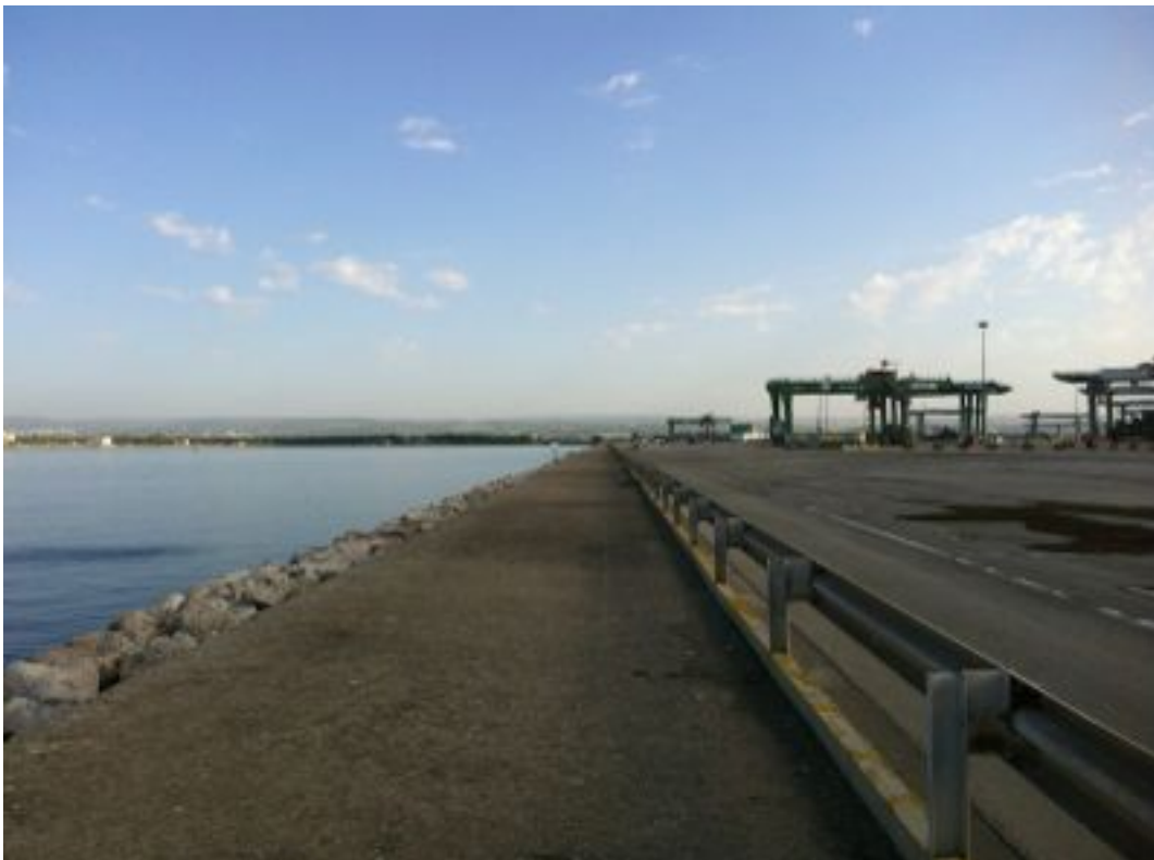
Foto 8. Panoramica frangiflutti lato Nord molo polisettoriale, direzione fotografica NE
