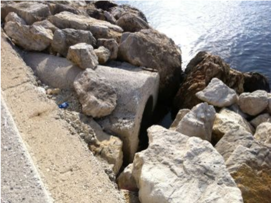
Foto 12. Porzione terminale primo canale di scarico acque prima pioggia del molo, dir. fotografica NE
