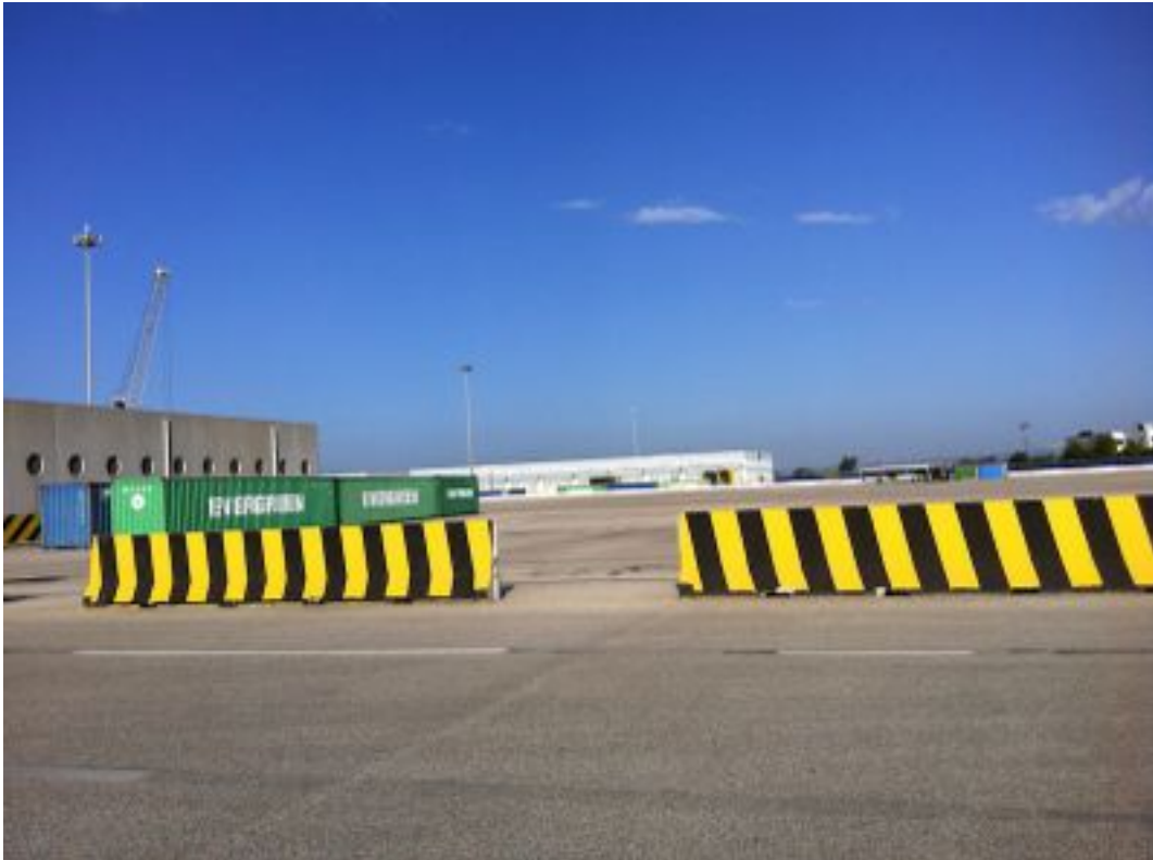
Foto 1. Panoramica piazzale radice molo polisetoriale, direzione fotografica NO
