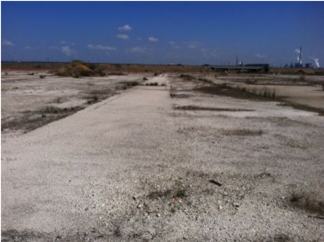
Foto 12. Panoramica piazzali cementati con cemento armato, dir. fotografica NE
