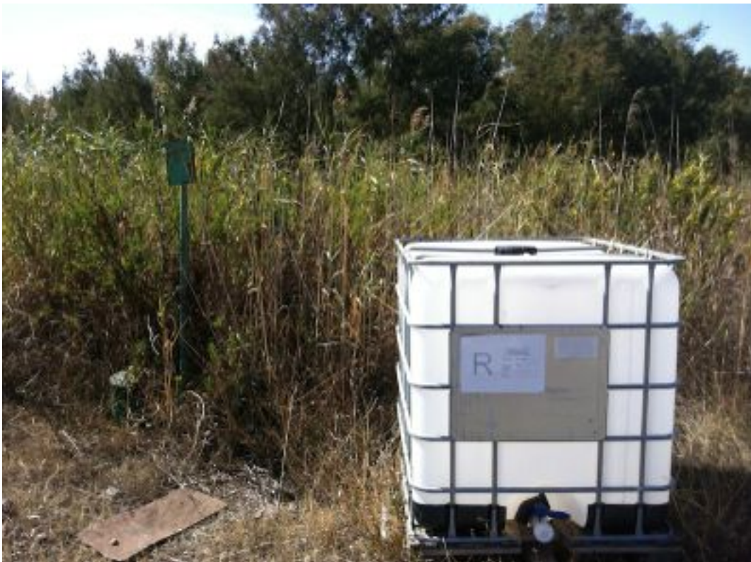
Foto 32. Particolare pozzo di bonifica di falda con serbatoio di accumulo acque prelevate, dir. fot. SO
