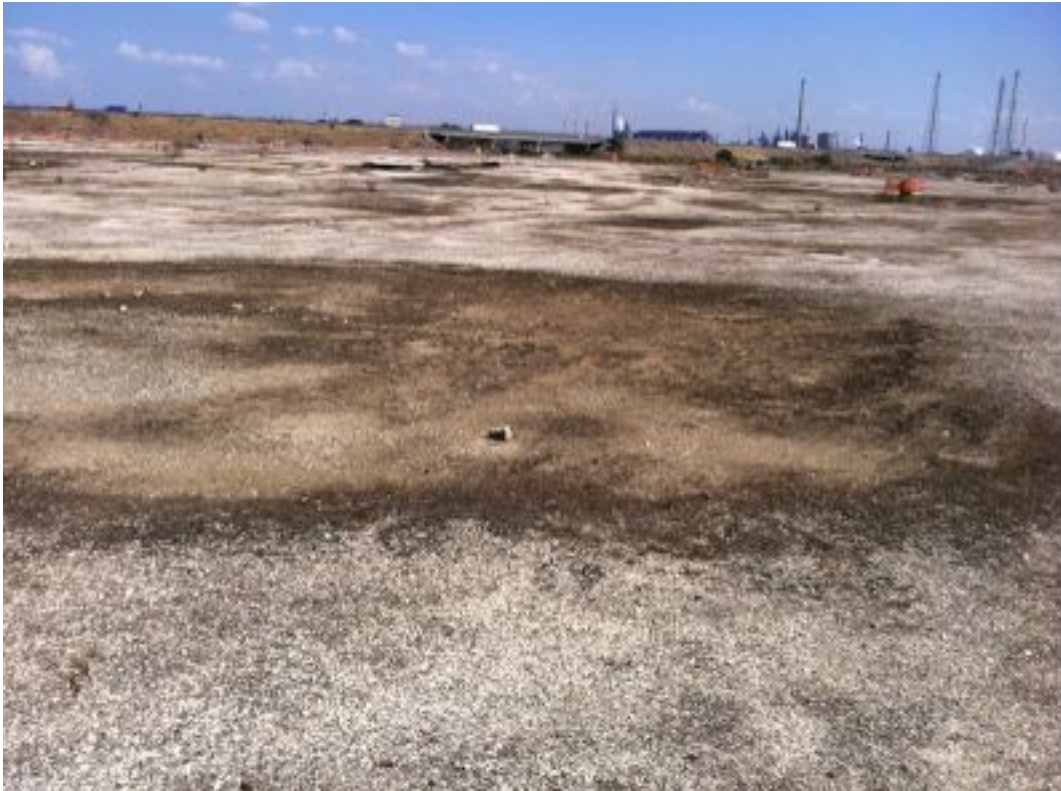
Foto 13. Panoramica piazzale in cemento armato con piccole depressioni, dir. fotografica NE
