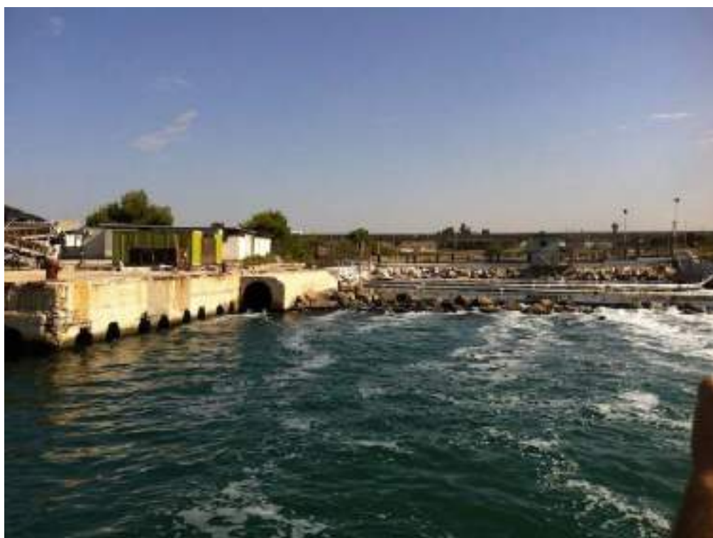
Figura 10.15 – Foto 2, Panoramica canale uscita acque scarichi industriali e civili, direzione fotografica NE
