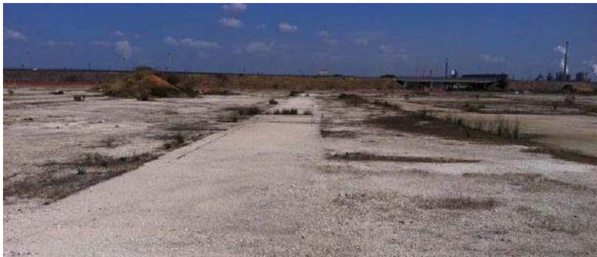
Figura 10.33 – Foto 12, Panoramica piazzali cementati con cemento armato, direzione fotografica NE
