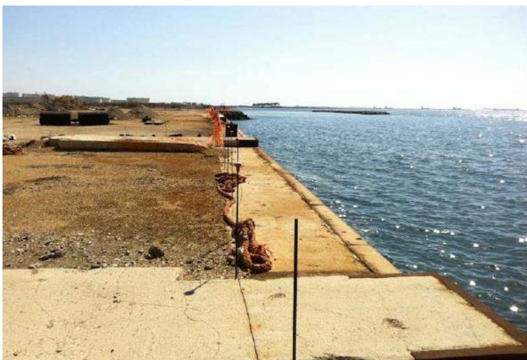
Figura 10.32 – Foto 9, Panoramica banchina in cemento armato, direzione fotografica SE
