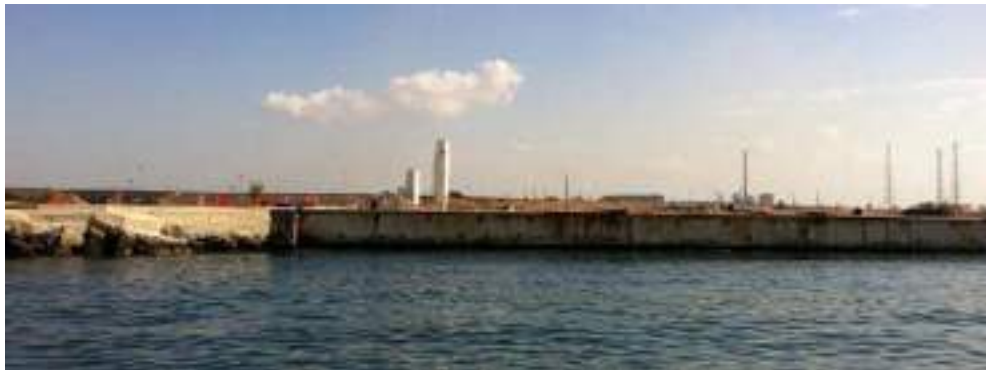
Figura 10.21 – Foto 13, Particolare banchina in muratura Yard Belleli, direzione fotografica NE
