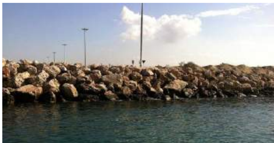
Figura 10.17 – Foto 6, Panoramica scogliera frangiflutto testata 5° sporgente, dir. fotografica SE
