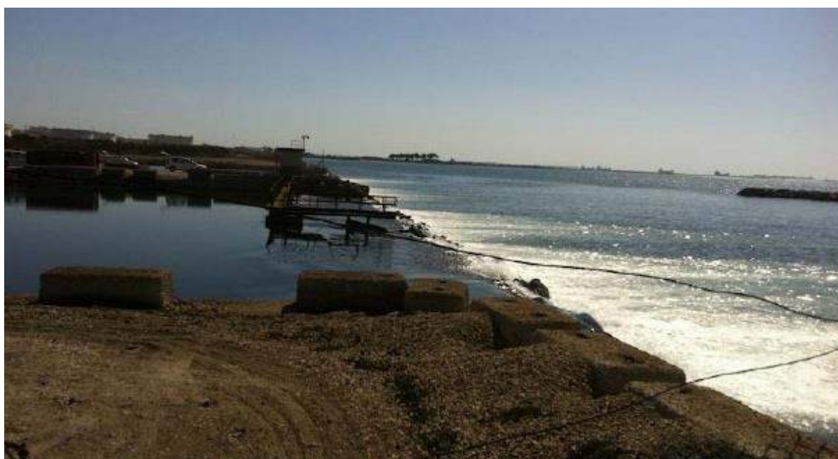
Figura 10.34 – Foto15, Panoramica area scarichi ILVA confine Sud area Belleli, direzione fotografica SE
