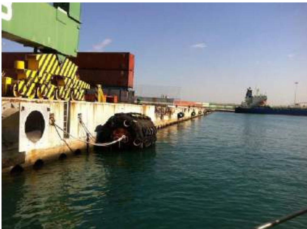
Figura 10.14 - Foto-1, Panoramica banchina di radice del Molo Polisettoriale, direzione fotografica NE
