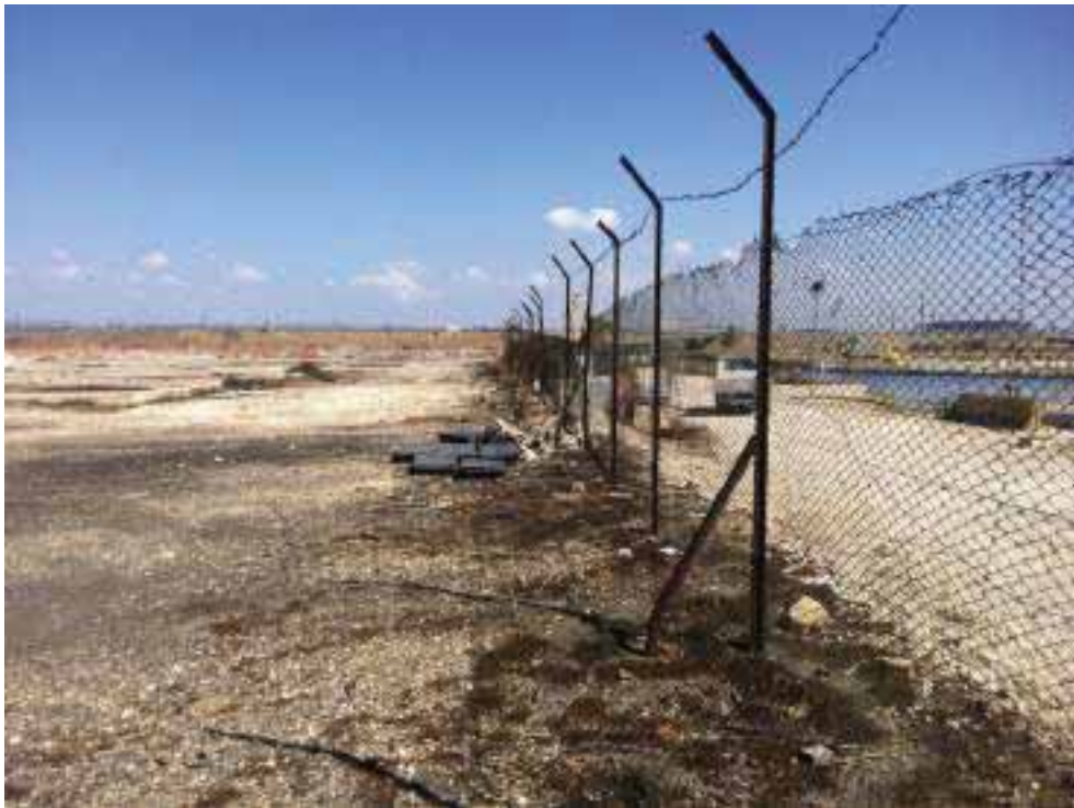
Foto 17. Recinzione di confine Sud are Yard Belleli, direzione fotografica NE
