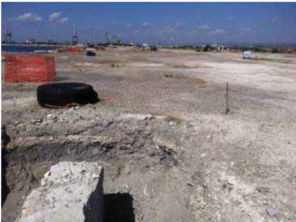
Foto 6. Particolare muri in cemento armato interrati area Yard Belleli, dir. fotografica NO
