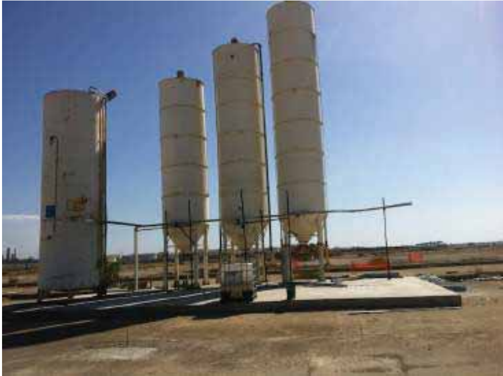
Foto 3. Particolare silos di cantiere area Yard Belleli, direzione fotografica SE.
