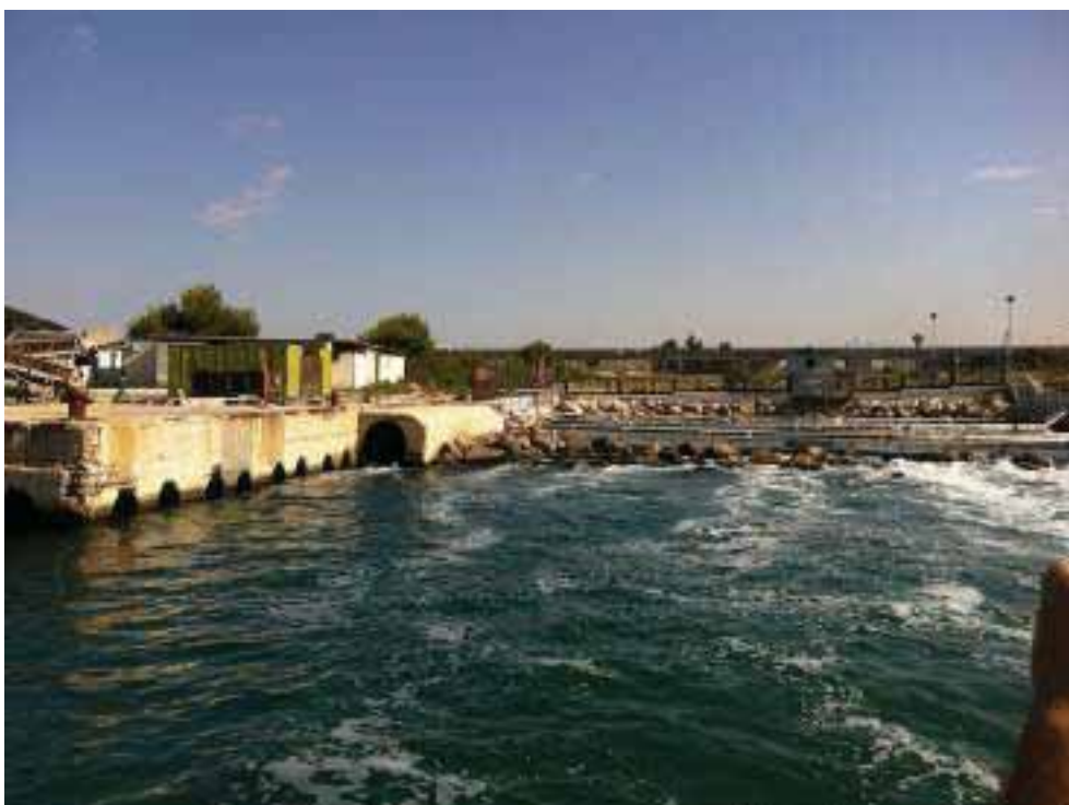
Foto 2. Panoramica canale uscita acque scarichi industriali e civili, direzione fotografica NE
