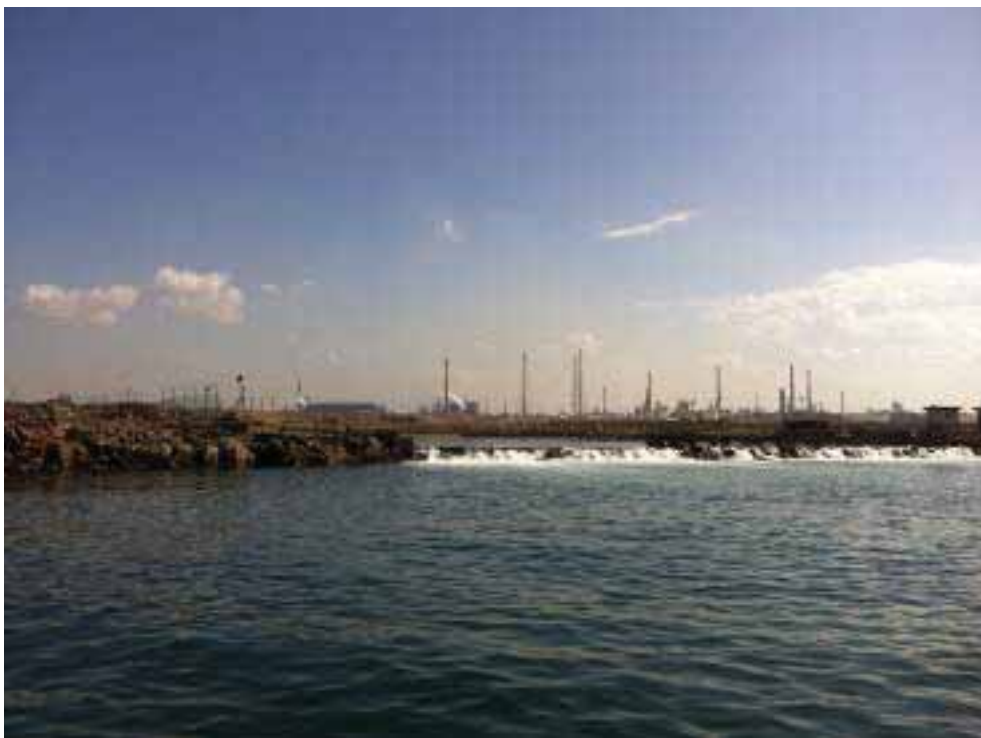
Foto 14. Panoramica scarichi industriali al confine Yard Belleli, direzione fotografica NE
