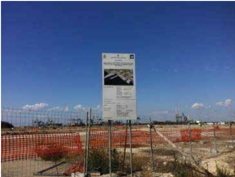
Foto 1. Ingresso area Yard Belleli, direzione fotografica Sud
