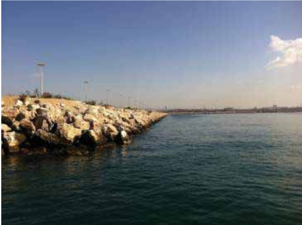
Foto 7. Panoramica argine esterno scogliera frangiflutto testata 5° sporgente, dir. fotografica SE.
