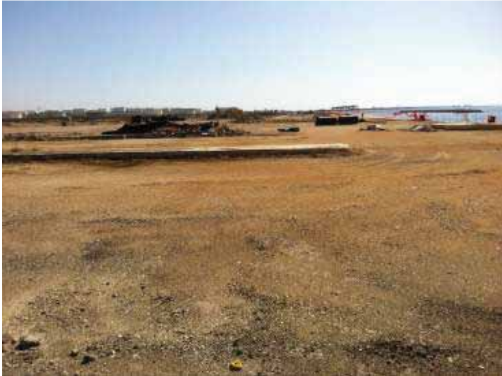
Foto 5. Panoramica porzione piazzali area Yard Belleli, direzione fotografica SE
