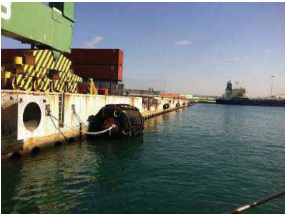
Foto 1. Panoramica banchina di radice del Molo Polisettoriale, direzione fotografica NE
