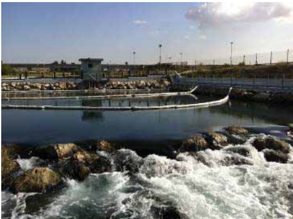
Foto 4. Particolare barriere di panne assorbenti su scarichi industriali, direzione fotografica NE
