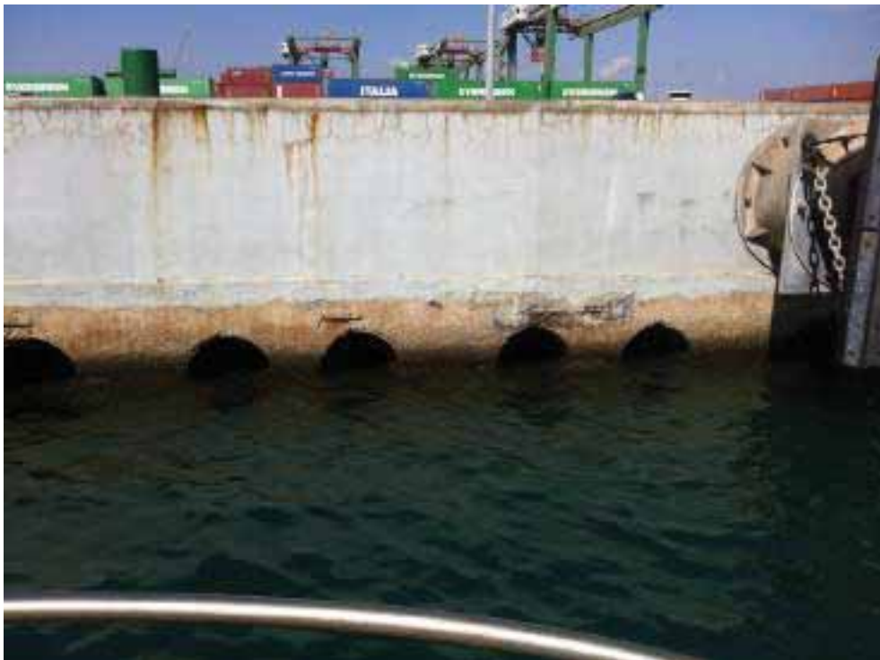
Foto 22. Particolare banchina con sistemi attenuatori onda riflessa, direzione fotografica NO
