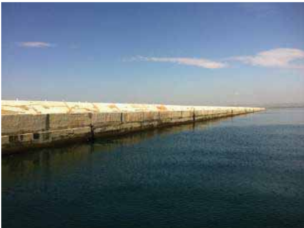
Foto 18. Panoramica banchina interna diga foranea porzione centrale, direzione fotografica NO
