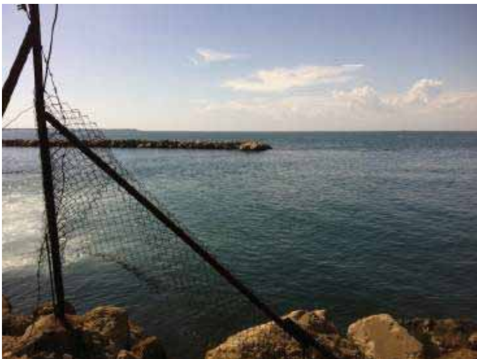
Foto 16. Panoramica diga frontale area scarichi ILVA, direzione fot. SO
