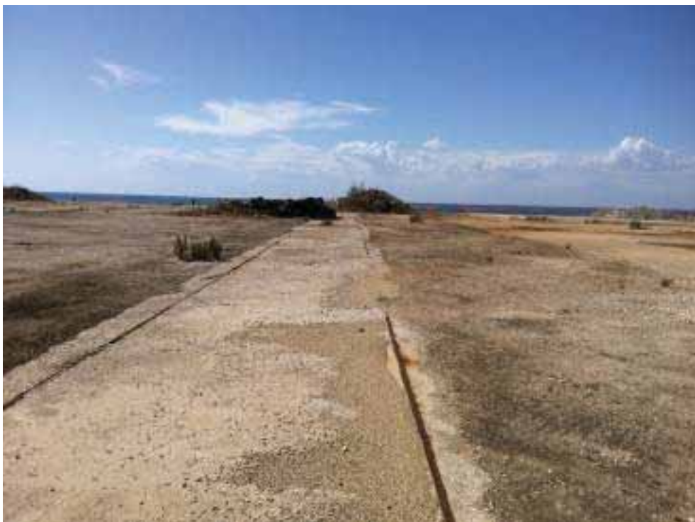
Foto 24. Particolare delle aree cementificate con binari, direzione fot. SO.
