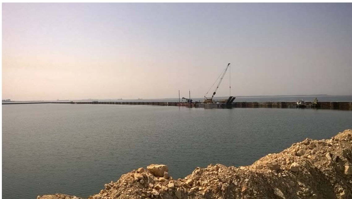
Fig. 5. Marginamento a mare _ Allineamento A-B - e B-C (situazione post 2019). Elementi infissi a quota con battipalo.
