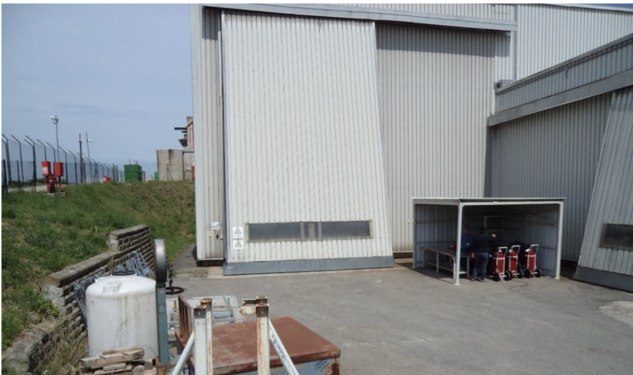
Figura 5-5 Ante operam: vista Nord Ovest con scarpata lato Nord
