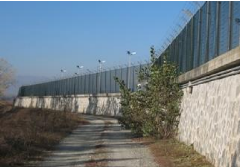
Fig. 6.4: Impianto Eurex, muro di difesa idraulica
