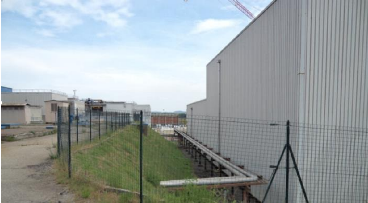
Fig. 8.5: Ante operam: vista Est con scarpata e pipe rack esistente (foto3)
