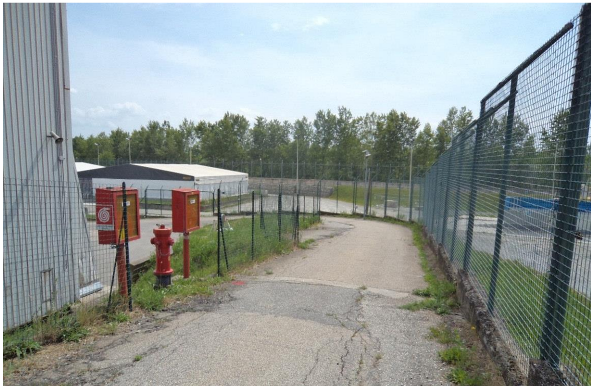
Fig. 8.6: Ante operam: vista Est strada d'accesso piazzale ed. 800 (foto4)
