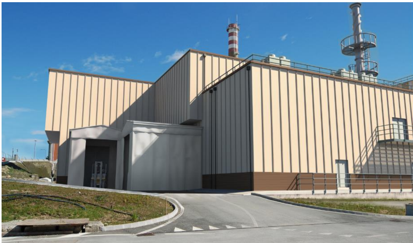
Fig. 11.5: Fotosimulazione post operam punto di ripresa interno al sito – con mitigazione cromatica
