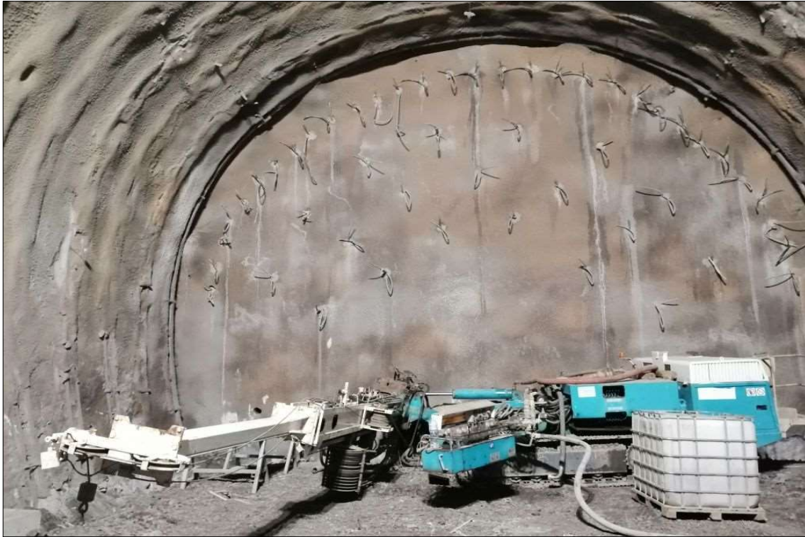
Postazione della perforatrice sul punto di indagine
