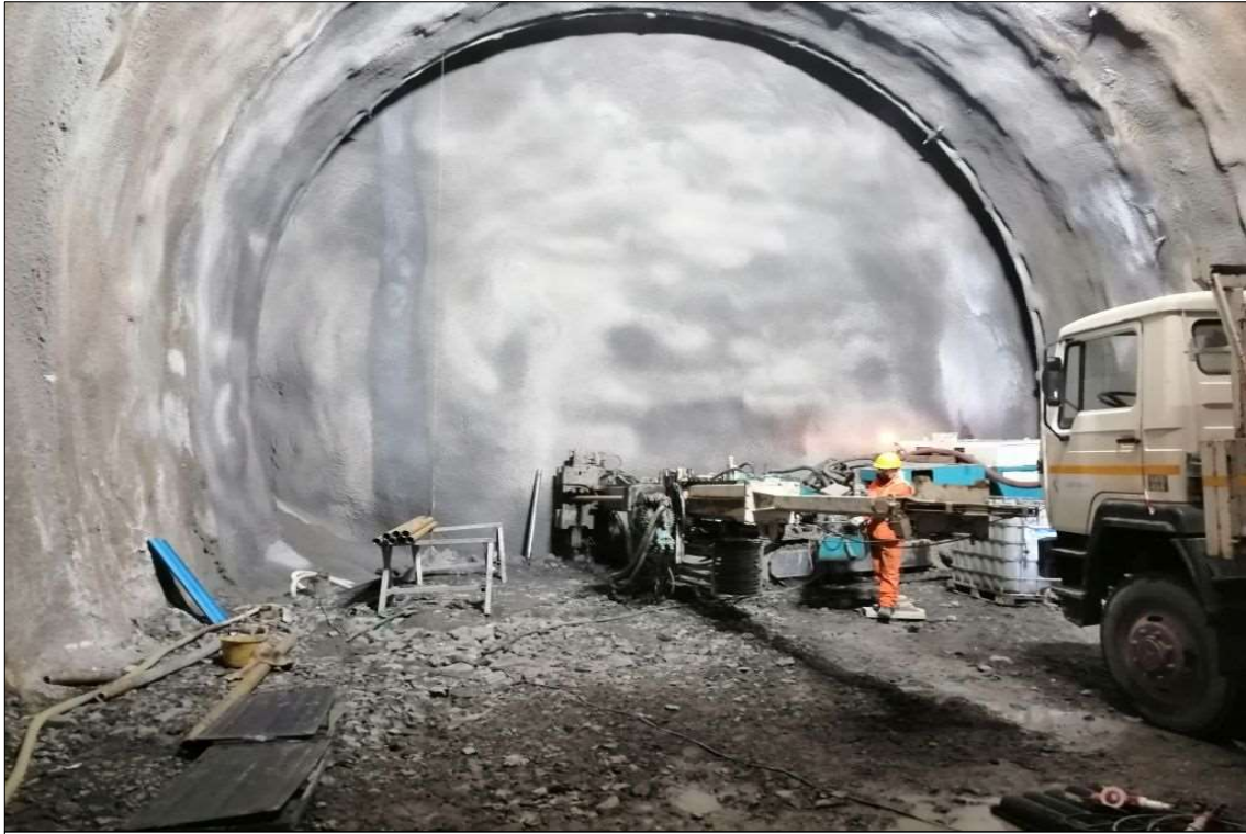
Postazione della perforatrice sul punto di indagine
