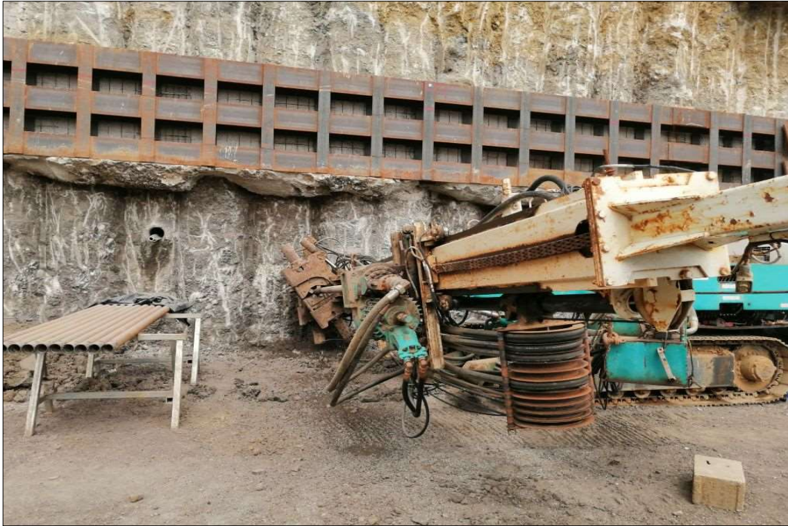
Postazione della perforatrice sul punto di indagine
