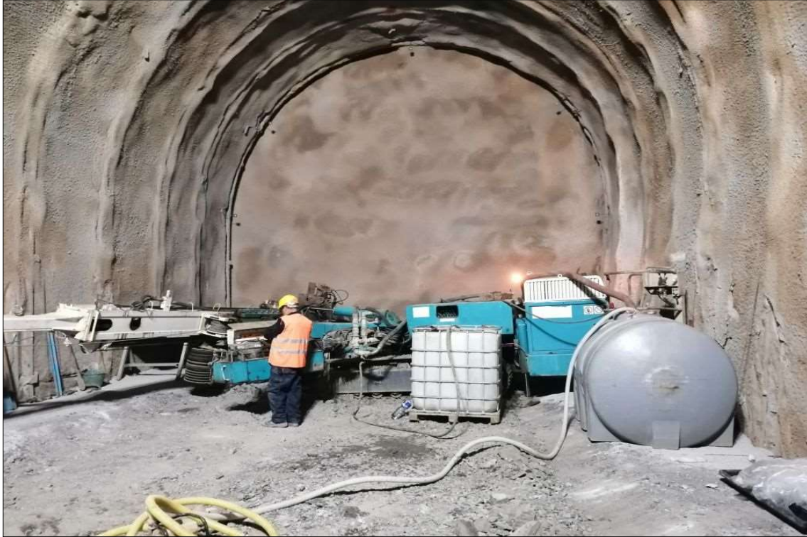
Postazione della perforatrice sul punto di indagine
