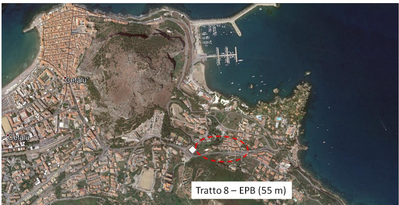
Figura 4. Tratto 8 da scavare con metodologia EPB della lunghezza complessiva di 55m
