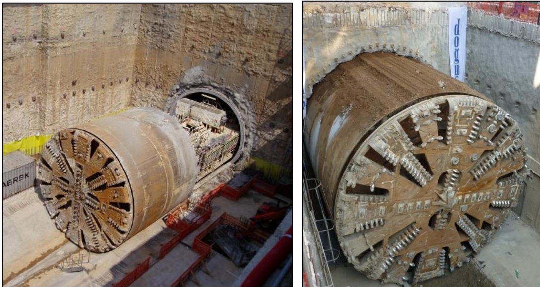
Figura 14. Conclusione dello scavo e fuoriuscita della talpa
