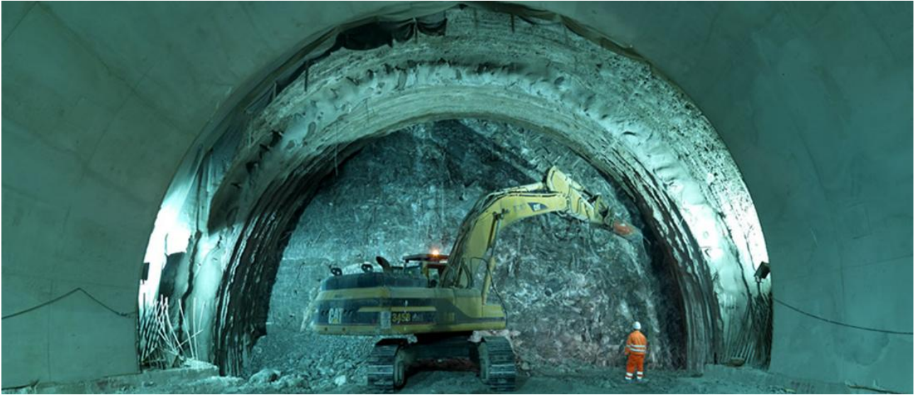
Figura 9. Esempio di impiego del metodo di scavo in tradizionale (fonte: website Toto Costruzioni , Galleria Carestia, Autostrada A24)
