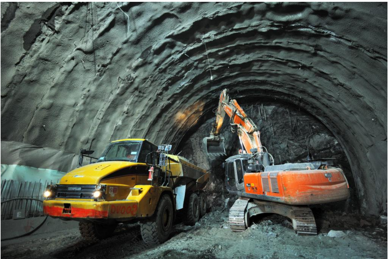
Figura 10. Esempio di impiego del metodo di scavo in tradizionale (fonte: website Toto Costruzioni , Galleria Allocco, Variante di Valico)
