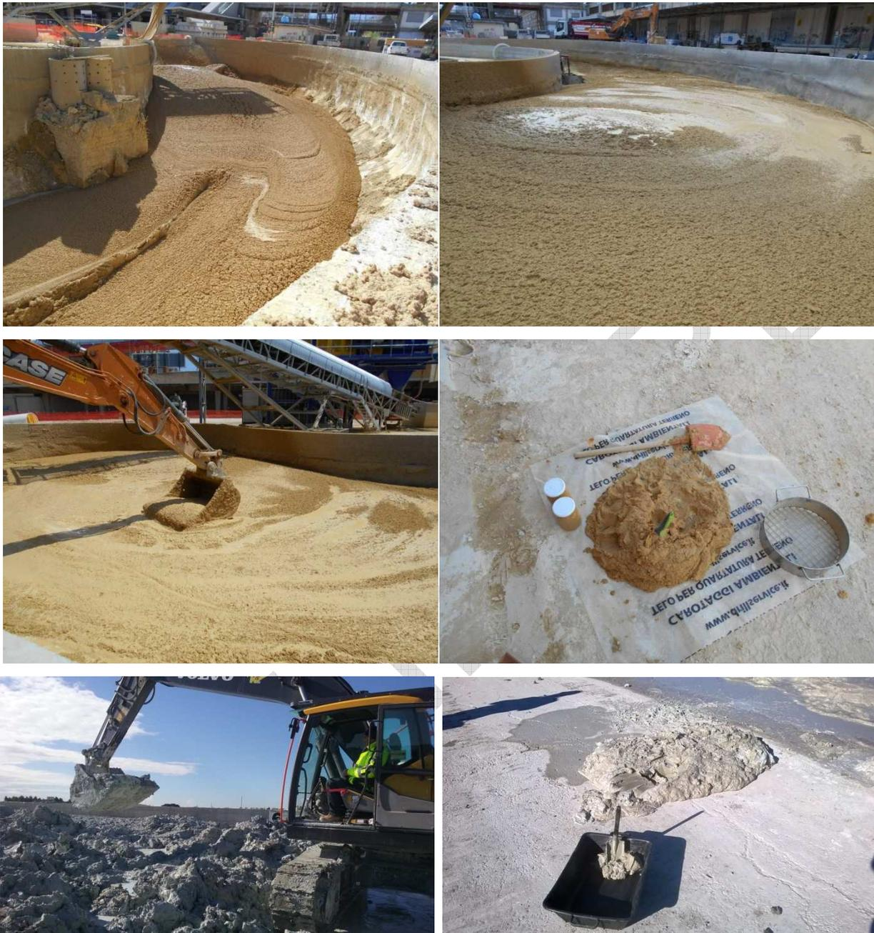
**Figura 6. Alcuni esempi della consistenza che può presentare il materiale condizionato e scavato con TBM**
