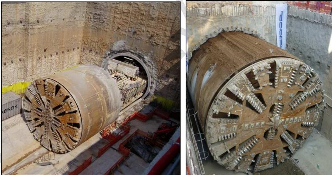
**Figura 4. Conclusione dello scavo e fuoriuscita della talpa**
