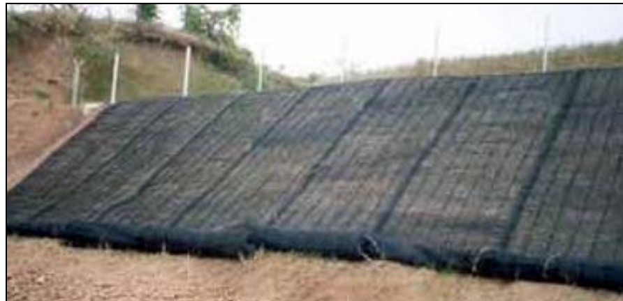
Figura 42: Bobine di geostuoia poste in opera su un versante stradale.
