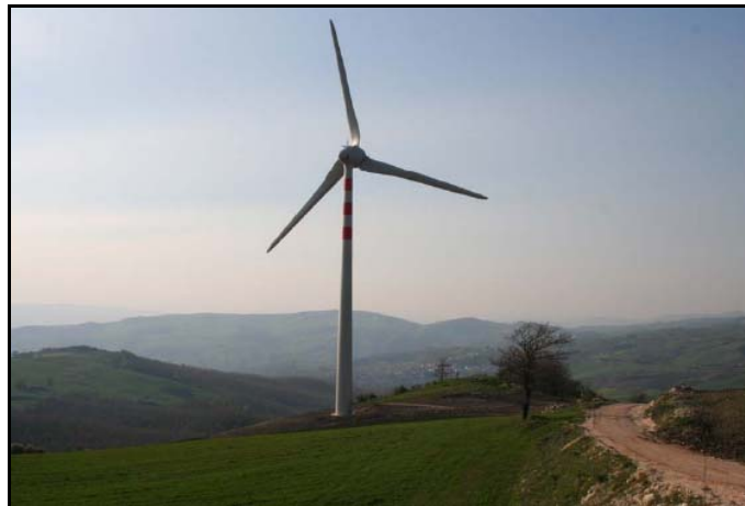
Figura 33: si nota come l'area di piazzola si riduca alla sola strada di servizio
