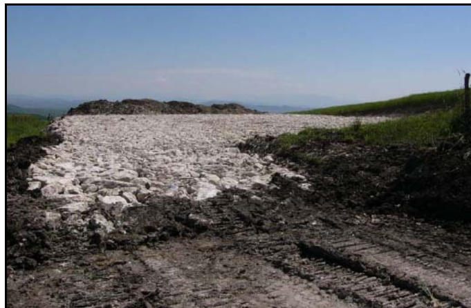
Figura 31: Piazzola in fase di costruzione.
