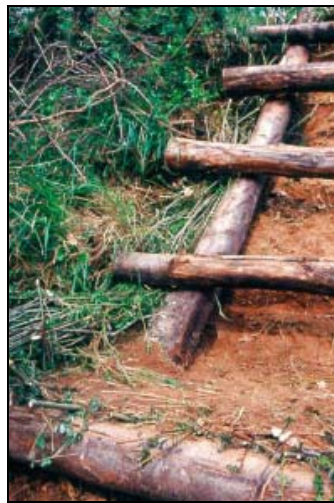
Figura 40: Particolare di fascinata viva .
