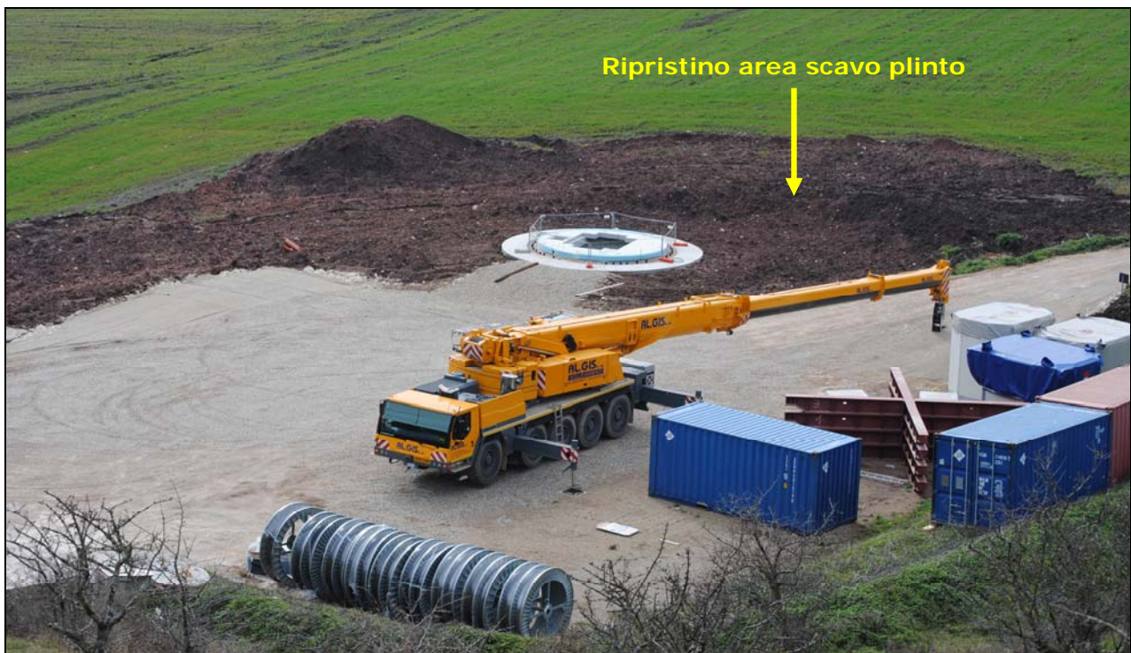
Figura 21: Rinterro e riprofilatura area plinto.
