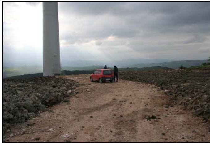
Figura 32: l'area di piazzola dopo i ripristini morfologici ed il riporto del terreno vegetale (successivamente andrà effettuato l'inerbimento).
