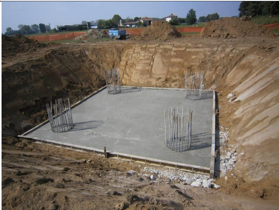
Figura 22 - Realizzazione di una fondazione su pali trivellati per un sostegno monostelo. Nell'immagine si può osservare una fondazione in fase di realizzazione. Si possono distinguere facilmente i quattro pali trivellati già realizzati e gettati (si osservano le "ripresе" delle quattro gabbie metalliche) ed il piano di "magrone" sul quale impostare il monoblocco in cls (fonte: Terna spa)
