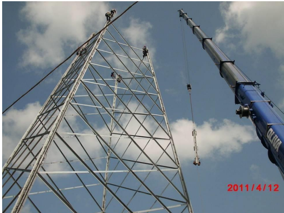
Figura 28 - Fasi di montaggio sostegno a traliccio (fonte: Terna spa)
