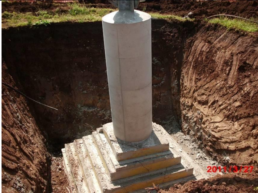
Figura 13 - Realizzazione di fondazioni superficiali tipo CR per un sostegno a traliccio. Nell'immagine si può osservare una fondazione CR appena "scasserata". Si possono distinguere facilmente la parte inferiore a parallelepipedi tronco piramidali ed il colonnino di raccordo con la "base" del sostegno (fonte: Terna spa)
