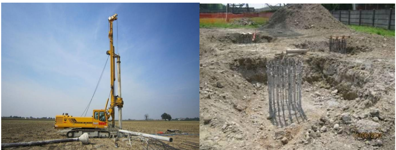
Figura 21 - Macchina operatrice per la realizzazione di pali trivellati (fonte: Terna spa)
