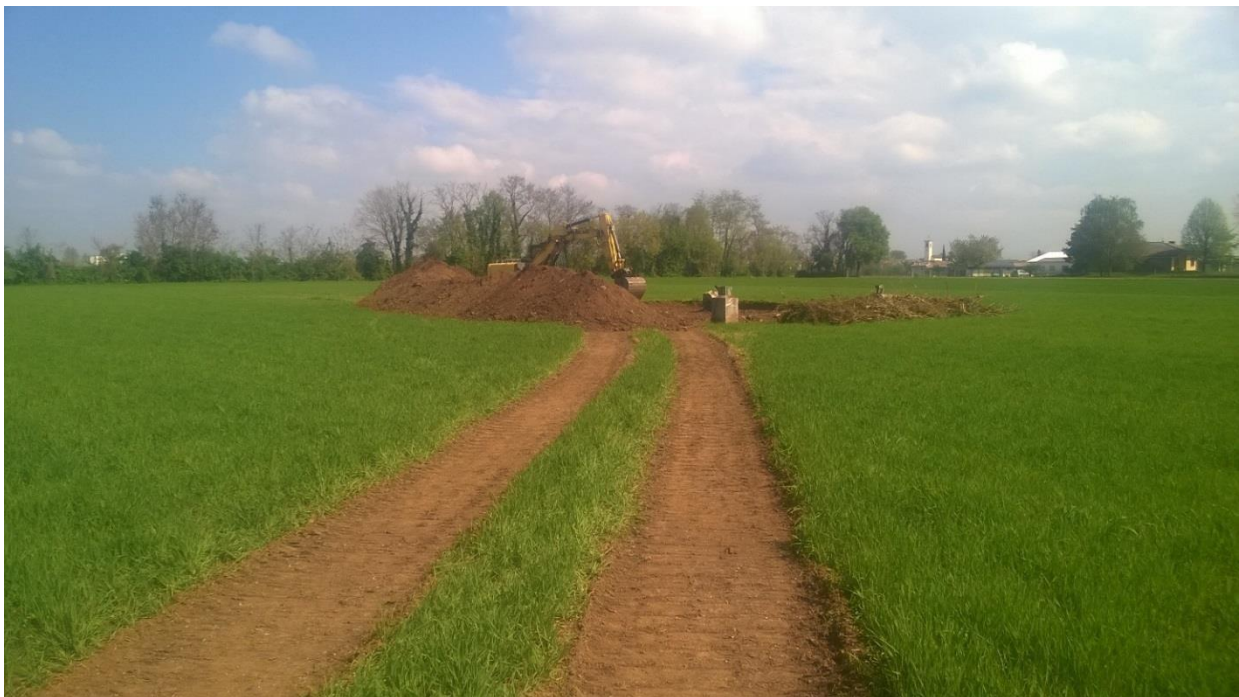
Figura 41- Esempio di pista temporanea su terreno agricolo (fonte: Terna spa)
