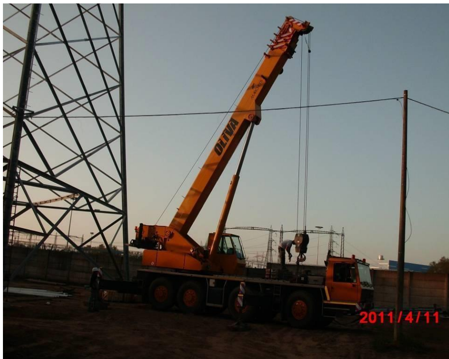
Figura 29 - Fasi di montaggio sostegno a traliccio (fonte: Terna spa)
