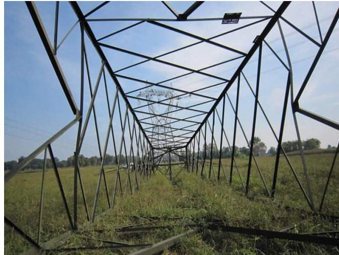
Figura 37 - Fasi demolizione di un sostegno a traliccio (fonte: Terna spa)
