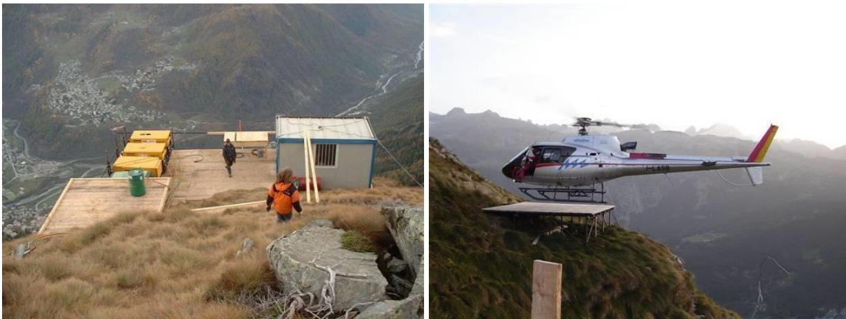
Figura 30 - Esempi di micro - cantieri in quota (fonte: Terna spa)
