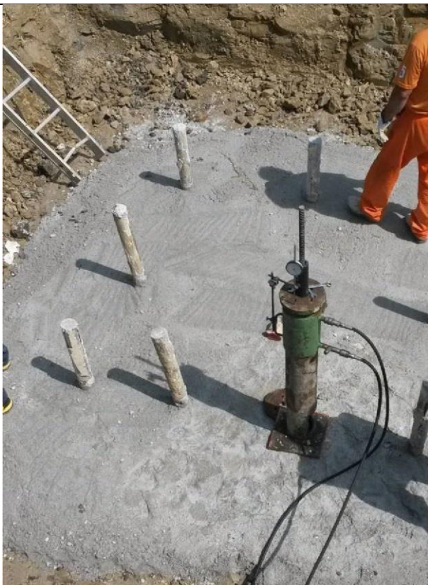
Figura 27 - Realizzazione di micropali tipo tubfix per un sostegno a traliccio; si possono osservare i 9 micropali già realizzati ed iniettati; in questa fase, prima dell'armatura e cassatura del plinto di fondazione, si sta eseguendo una prova di tenuta del micropalo allo strappamento, al fine di verificare la corretta progettazione e realizzazione dello stesso(fonte: Terna spa)
