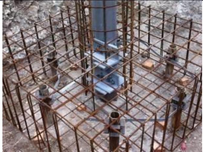
Figura 24 - Esempio di realizzazione di una fondazione su micropali tipo tubfix. Nell'immagine di destra si può notare il particolare del raccordo tra i tubolari metallici dei micropali con l'armatura del plinto di fondazione; al centro del plinto si nota il moncone del sostegno (elemento di raccordo tra il sostegno e la fondazione) il quale viene annegato nella fondazione stessa (fonte: Terna spa)
