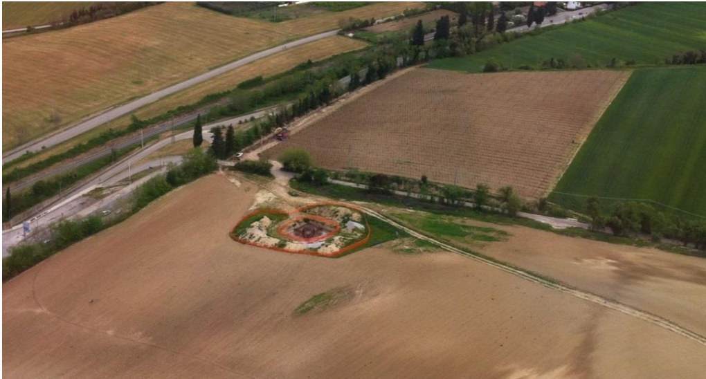
Figura 9 - Area Sostegno veduta dall'alto dell'estensione complessiva del micro-cantiere (fonte: Terna spa)
