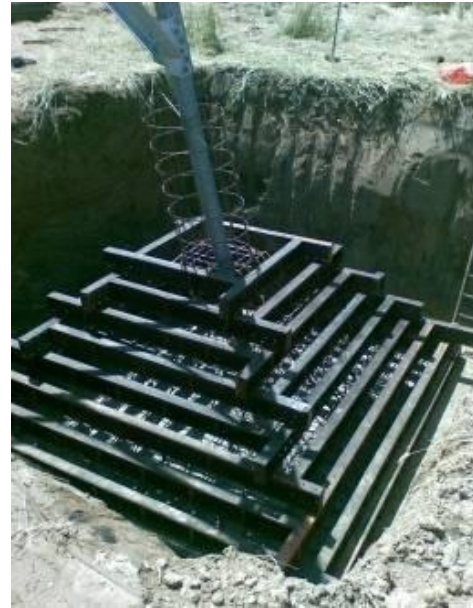
Figura 11 - Esempio di realizzazione di una fondazione a plinto con riseghe. Nell'immagine di sinistra di può osservare un disegno di progetto mentre nell'immagine di destra la fase di cassetatura della fondazione (fonte: Terna spa)
