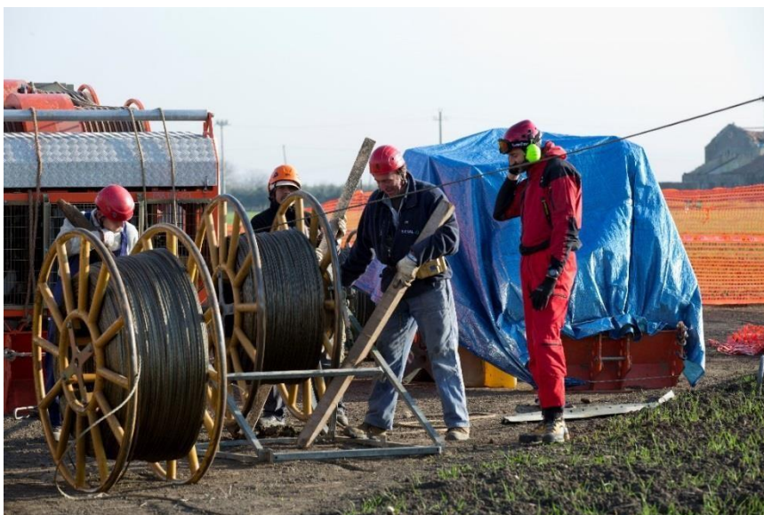
Figura 36 - Fasi di tesatura della linea elettrica (fonte: Terna spa)
