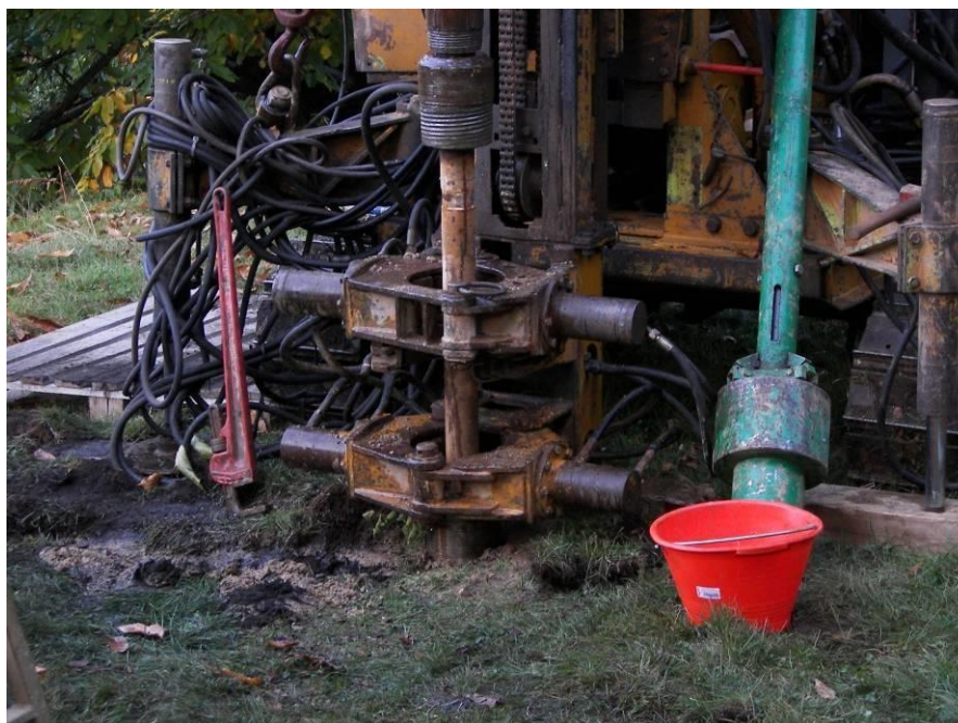
Figura 25 - Macchina operatrice per la realizzazione di micropali tubfix; sistema di scavo a rotopercussione (fonte: Terna spa)
