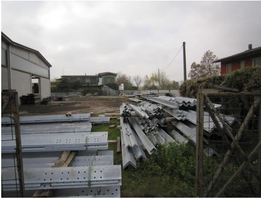
Figura 4 - Area centrale – Deposito materiale (fonte: Terna spa)
