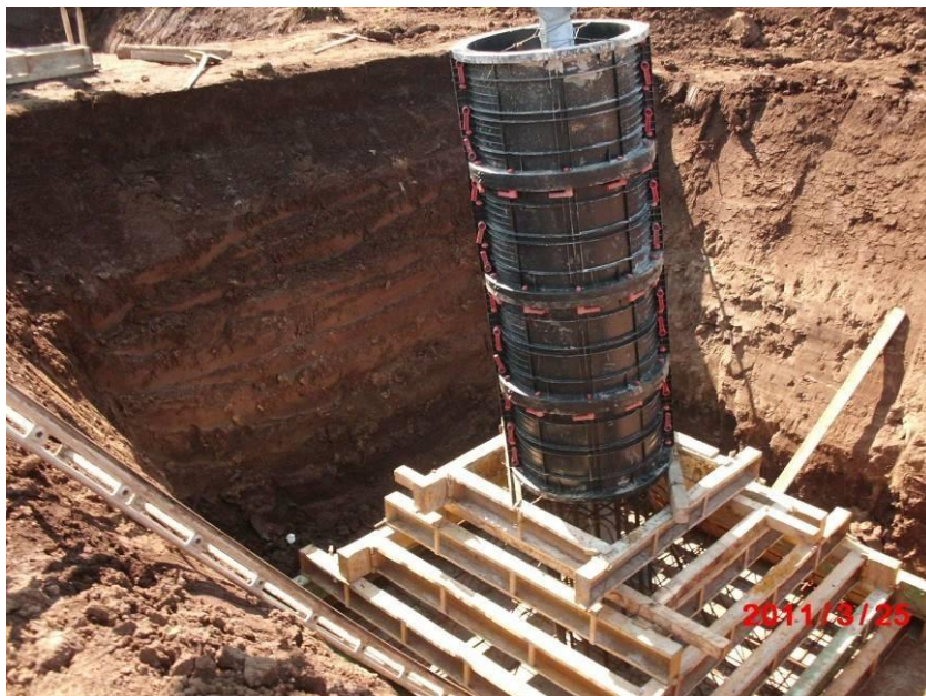
Figura 12 - Realizzazione di fondazioni superficiali tipo CR per un sostegno a traliccio. Nell'immagine si può osservare la fase di cassetatura (fonte: Terna spa)
