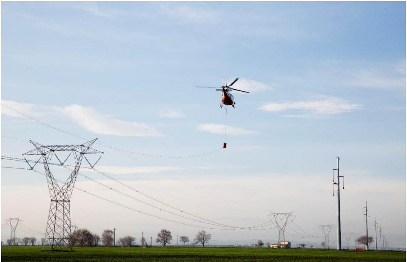
Figura 34 - Utilizzo dell'elicottero per la stesura della fune pilota (fonte: Terna spa)
