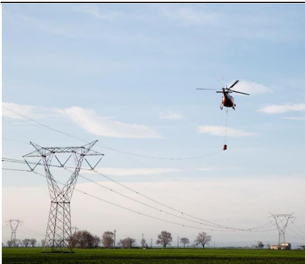
Figura 2.7 Utilizzo dell'elicottero per la stesura della fune pilota
