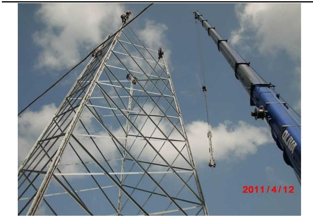
Figura 2.6 Fasi di montaggio di un sostegno a traliccio
