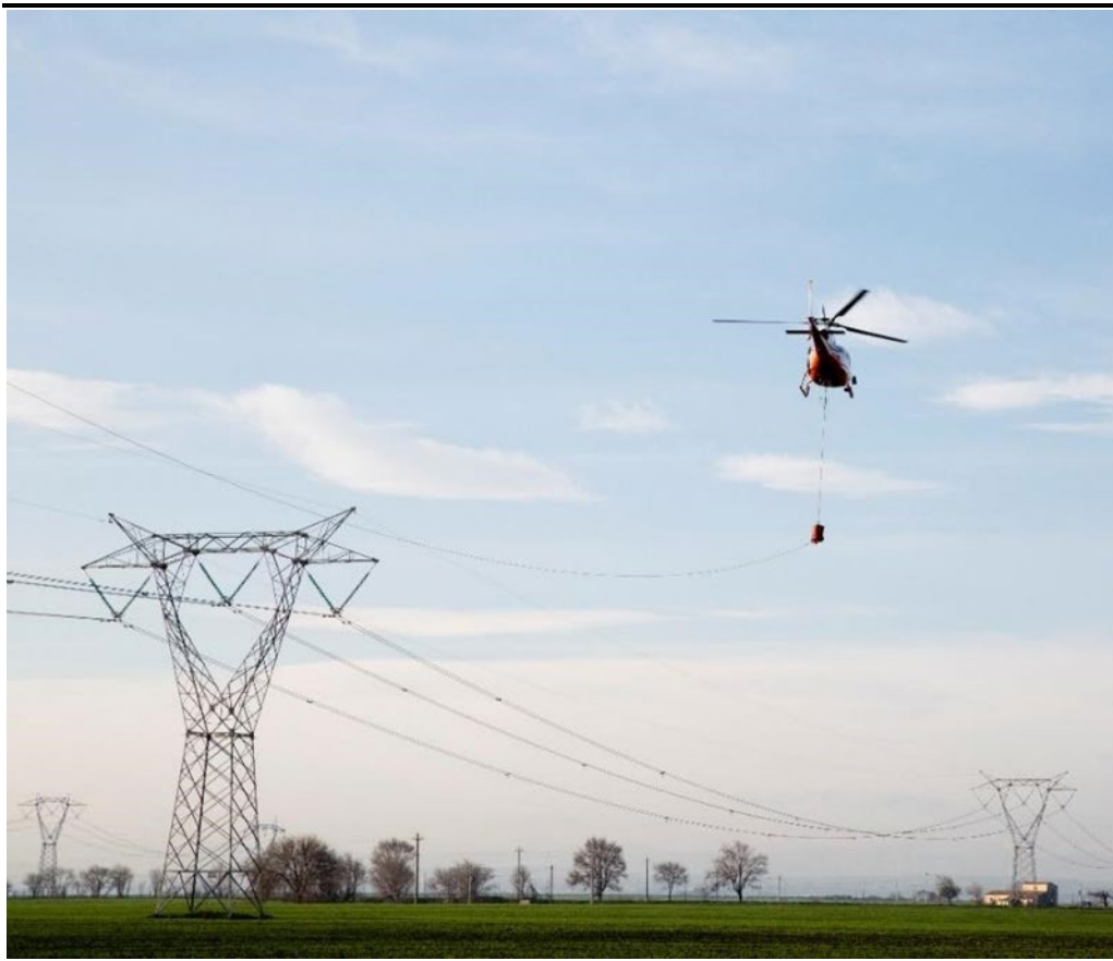
Figura 3.19 Utilizzo dell'elicottero per la stesura della fune pilota
