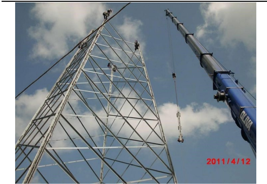
Figura 3.18 Fasi di montaggio di un sostegno a traliccio
