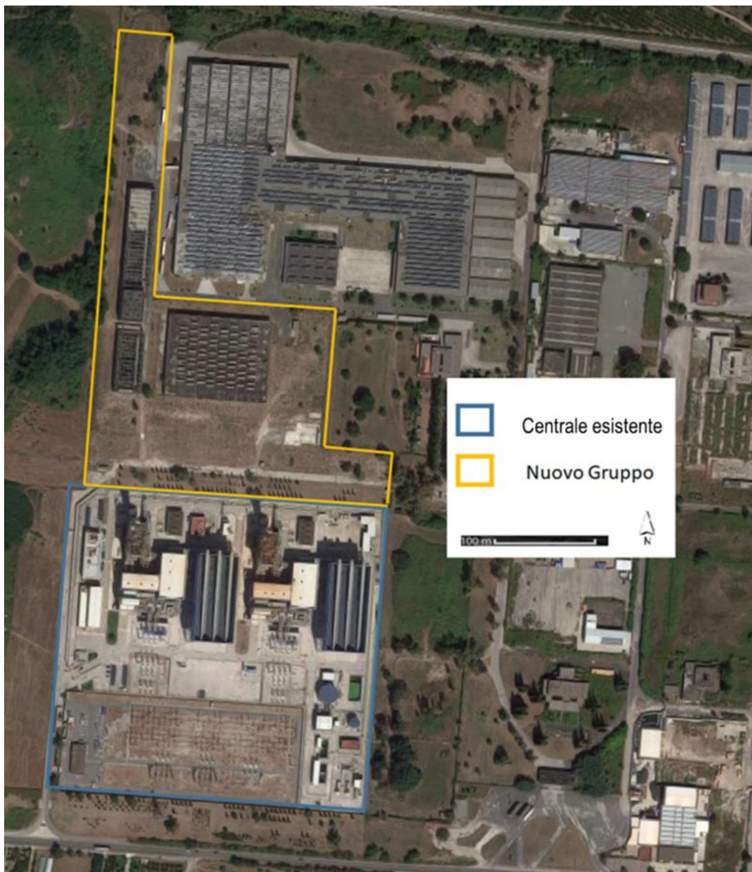
Figura 3 - Vista Aerea dell'Area di Ubicazione del Nuovo Gruppo di Generazione e della Centrale esistente
