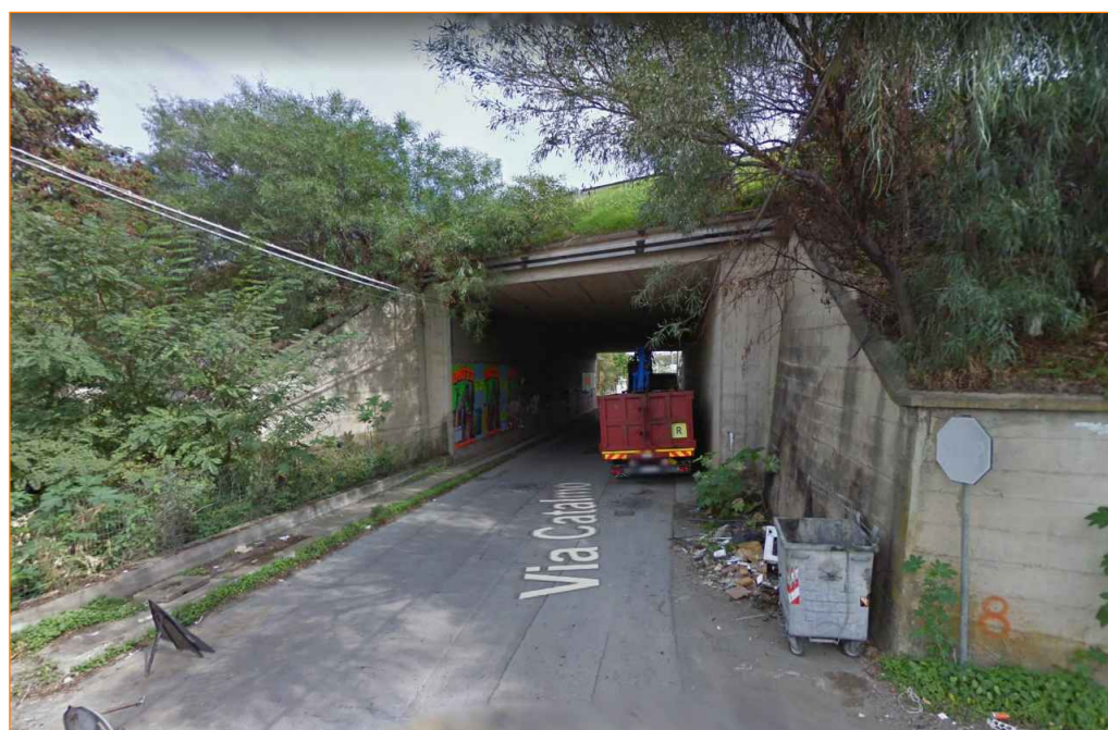
via Catalano - Sottovia A18 - lato monte
