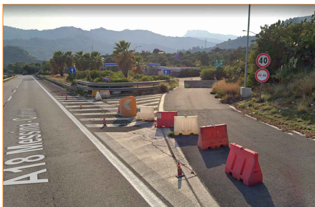
A18 - Accesso area di servizio dismessa, direz. Catania
