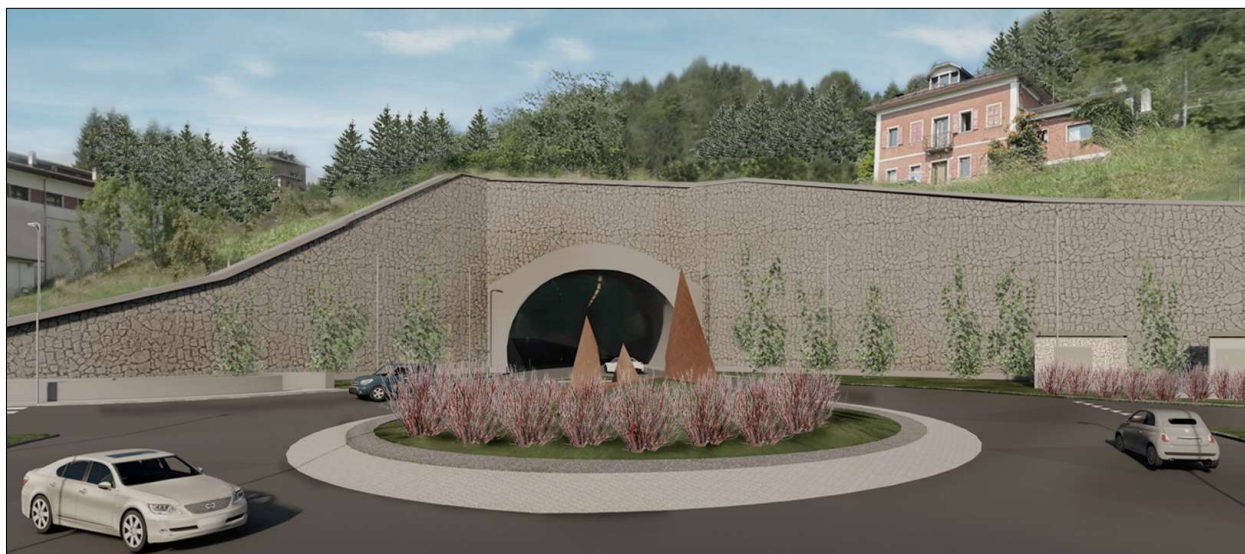
Figura 44 – Paratie di sostegno imbocco est: rinverdimento con rampicanti.
