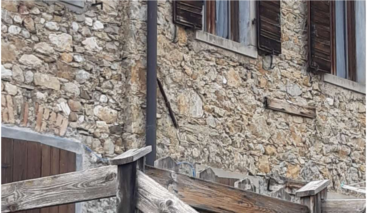
Figura 29 – Fotografia particolare – tiranti su muratura
