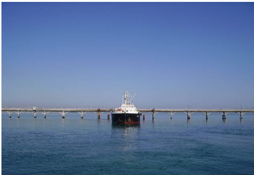
Figura III.5 Veduta del pontile lato Sud-Est (Braccio 1)
