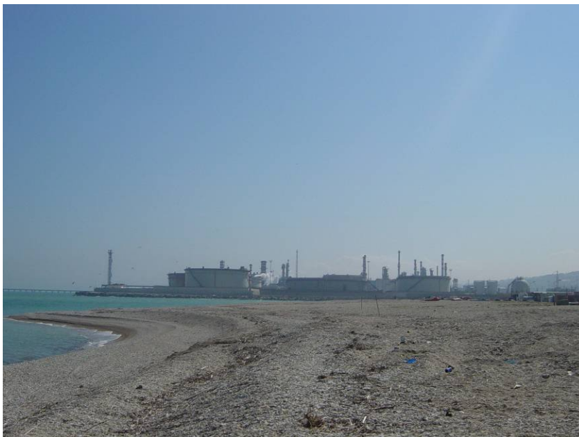
Figura IV. 44 Vista del sito api e della fascia costiera lato Senigallia
