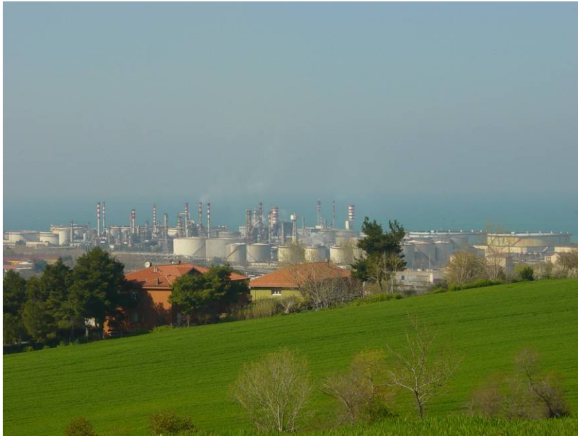
Figura IV. 43 Vista del sito api – lato sud
