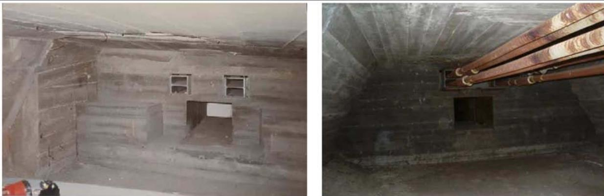
Figura 21 - vista del blocco di testata della mensola su pila 4 a getto ultimato (a) e barre di cucitura (b)
