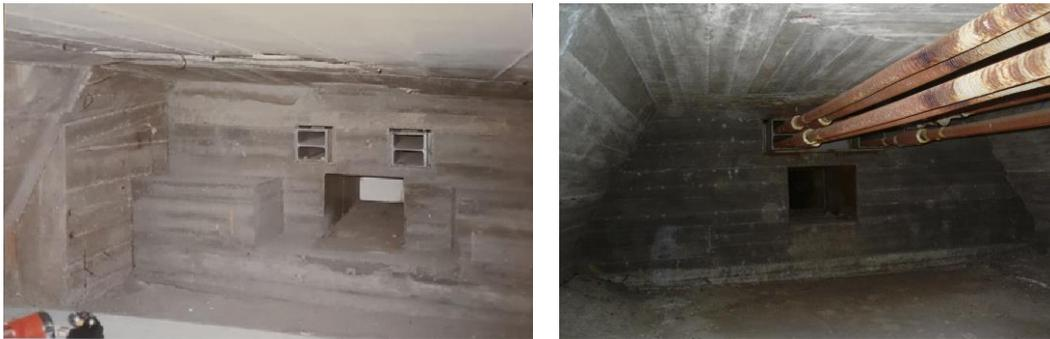
Figura 10: vista del blocco di testata della mensola su pila 4 a getto ultimato (a) e barre di cucitura (b)
