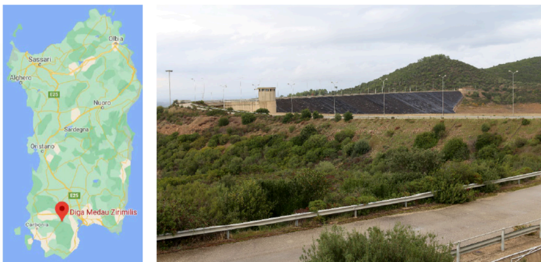
Fig. 1 Localizzazione e ripresa fotografica dell'area dell'intervento
