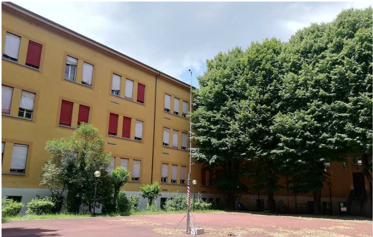
Figura 30 Posizionamento della strumentazione (centro cortile)
