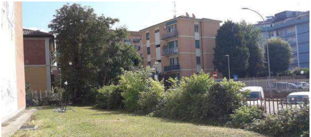
Figura 34 Posizionamento della strumentazione (lato strada)
