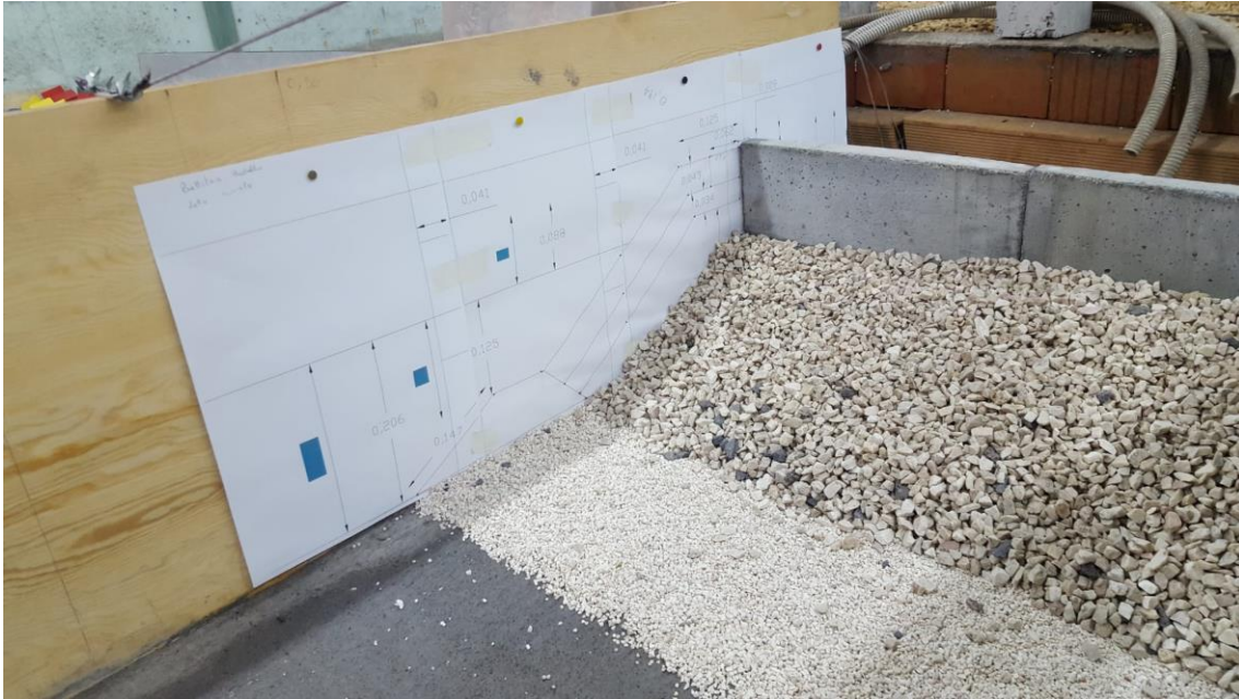
Figura 4.23 Posa in opera della parte interna del nucleo e del secondo strato filtro: configurazione finale.
