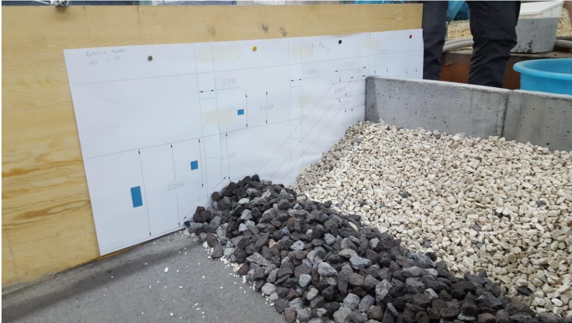
Figura 4.25 Posa in opera del materiale basaltico (diametro teorico compreso tra 16.1-18.1 mm) per la realizzazione della berma: configurazione finale.
