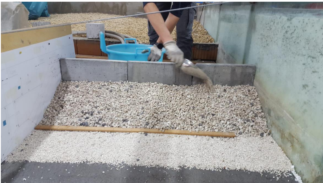
Figura 4.22 Posa in opera della parte interna del nucleo e del secondo strato filtro.
