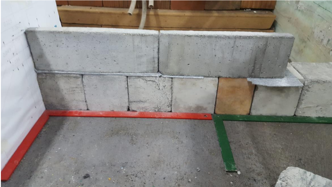
Figura 4.19 Sistemazione del muro paraonde: impiego di geotessuto per la sistemazione allineata delle diversi moduli del muro paraonde.
