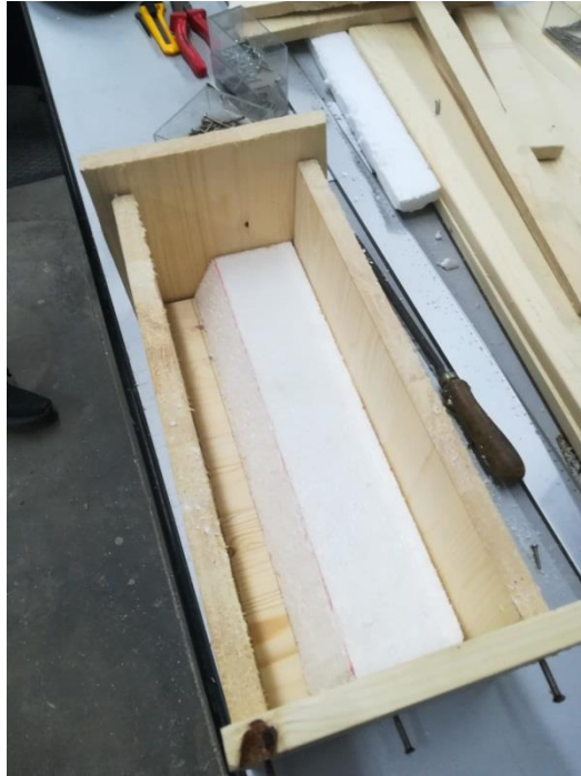
Figura 4.17 Casseforme di legno appositamente realizzate per la realizzazione dei moduli del muro paraonde.
