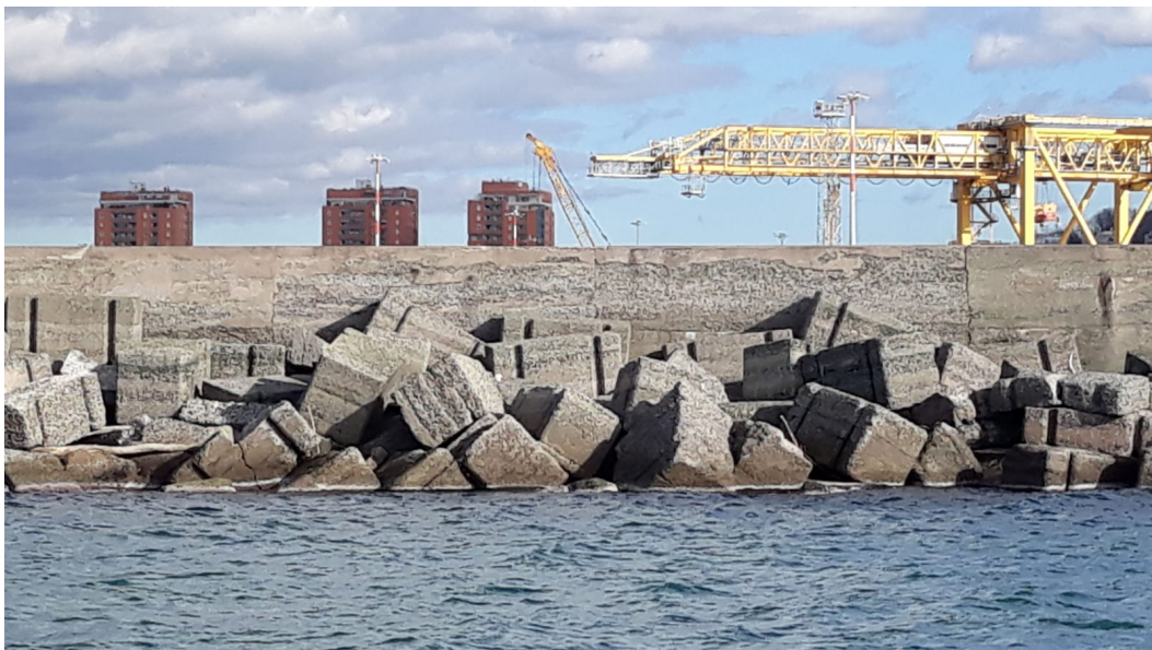
FIGURA 3-12 - RIFIORIMENTO DELLA DIGA LATO MARE (POST 1955)
