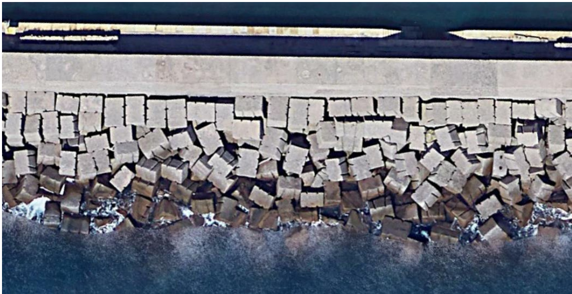
FIGURA 9-8 - ELEMENTI IN CALCESTRUZZO POSTI A DIFESA DELLA DIGA ESISTENTE DOPO LA MAREGGIATA DEL 1955 – VISTA DALL'ALTO
