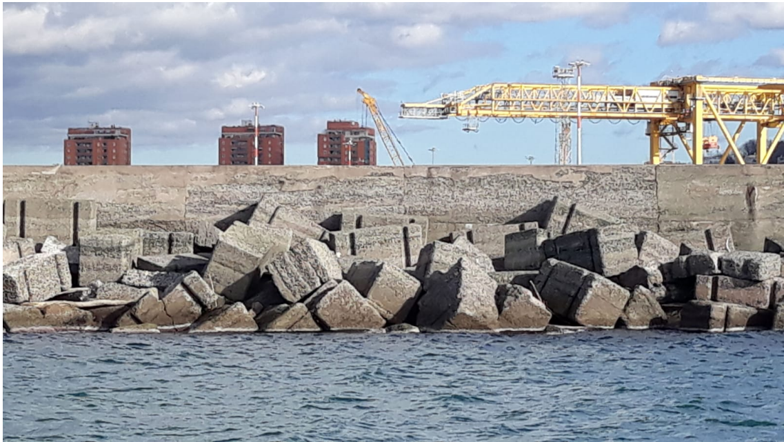
FIGURA 9-7 - ELEMENTI IN CALCESTRUZZO POSTI A DIFESA DELLA DIGA ESISTENTE DOPO LA MAREGGIATA DEL 1955 – VISTA DAL LATO MARE
