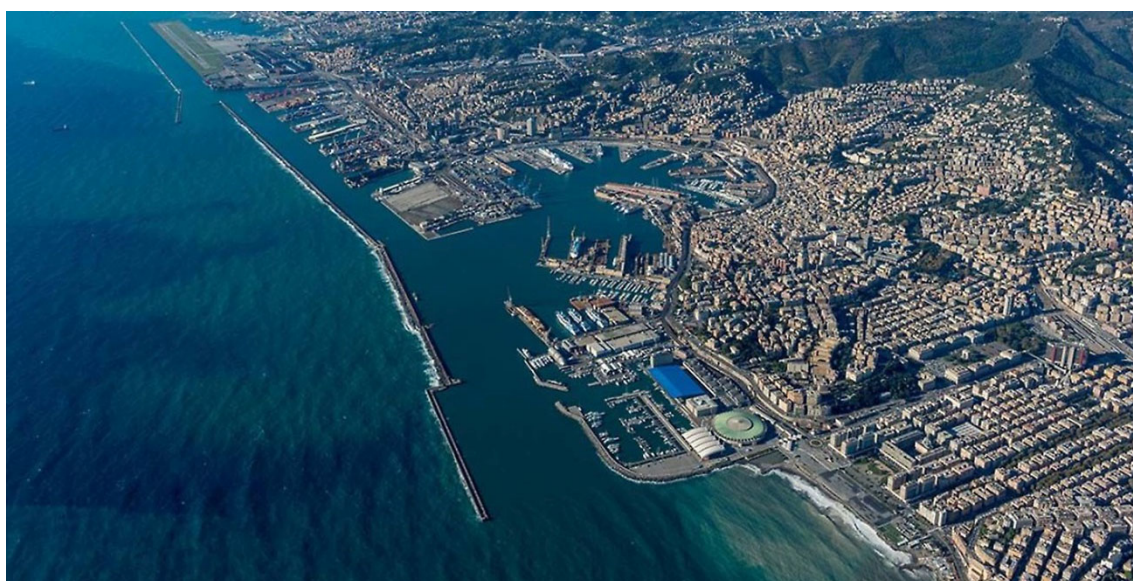
FIGURA 2-1 - DIGA FORANEA ESISTENTE – VISTA AEREA DA LEVANTE
