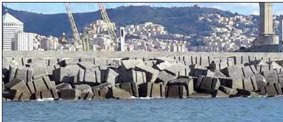
**Figura 49 - Particolare del rifiorimento della diga mediante massi in calcestruzzo realizzato dopo il 1955 (Ballerini 2020)**
