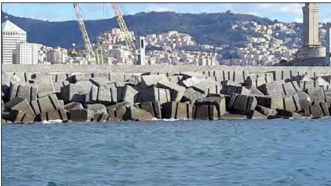
**Figura 61. Particolare del rifiorimento della diga mediante massi in calcestruzzo realizzato dopo il 1955 (BALLERINI 2020).**
