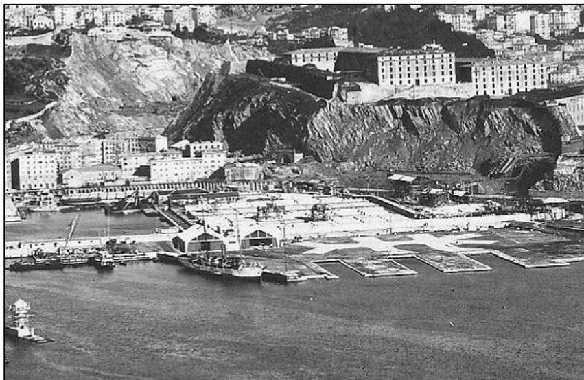
Figura 76. La cava di estrazione dei blocchi utilizzati per la costruzione dei sottostanti moli del Bacino Benito Mussolini (<https://www.pinterest.it/pin/13510867615458872/>).
