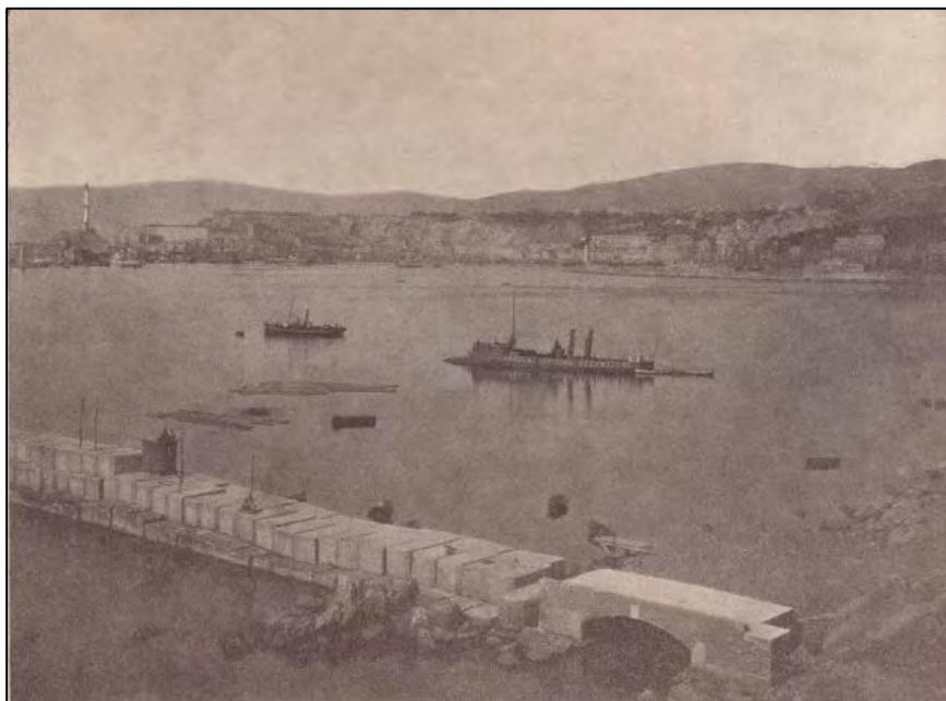
**Figura 41. Lavori di fondazione del Molo Giano tra il 1883 e il 1888. Si noti la tecnica di giustapposizione dei massi costituenti la struttura ([www.ceraunavoltagenova.it](http://www.ceraunavoltagenova.it)).**
