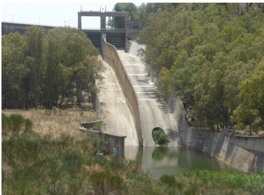
Figura 1 Diga del Pozzillo, scarico di superficie e sbocco della galleria dello scarico di fondo (fonte: Elaborato APO0308RE_D_C “Studio Preliminare Ambientale”, Aprile 2021)
