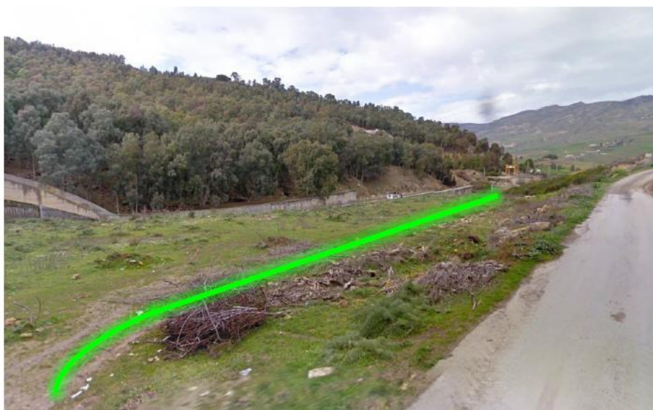
Figura 7 Esempio di criticità per la quale è previsto un intervento di Tipo 4 (fonte: Elaborato GEN0102RED “Relazione generale”, Aprile 2021)
