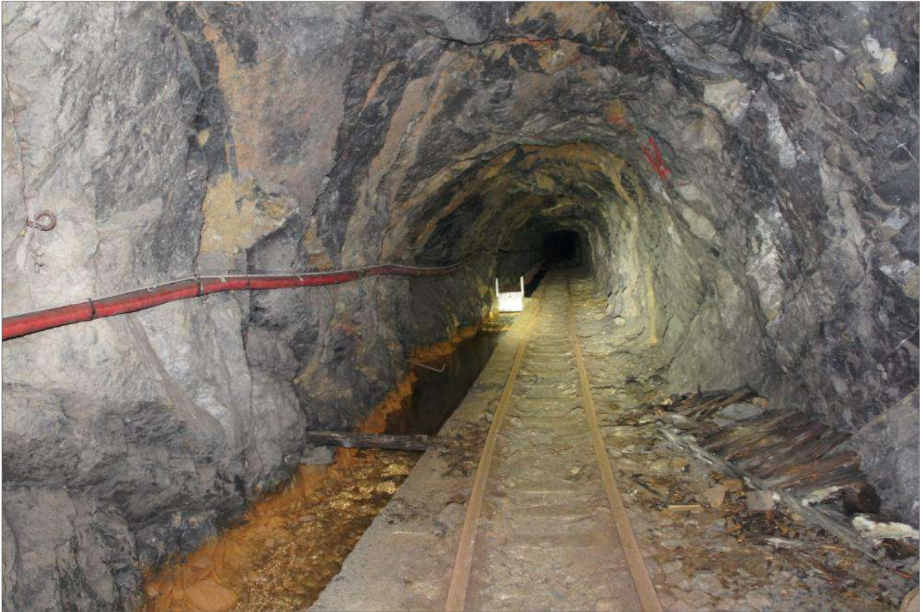
Figura 7.5 Esempio di strutture persistenti che formano cunei (Formazione Gorno)
