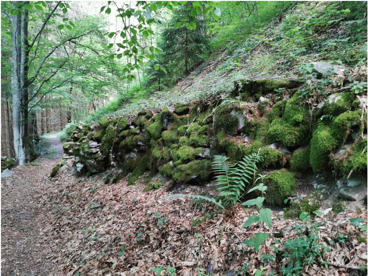
Fig. 16 muretti a secco presenti in prossimità dei primi portali
