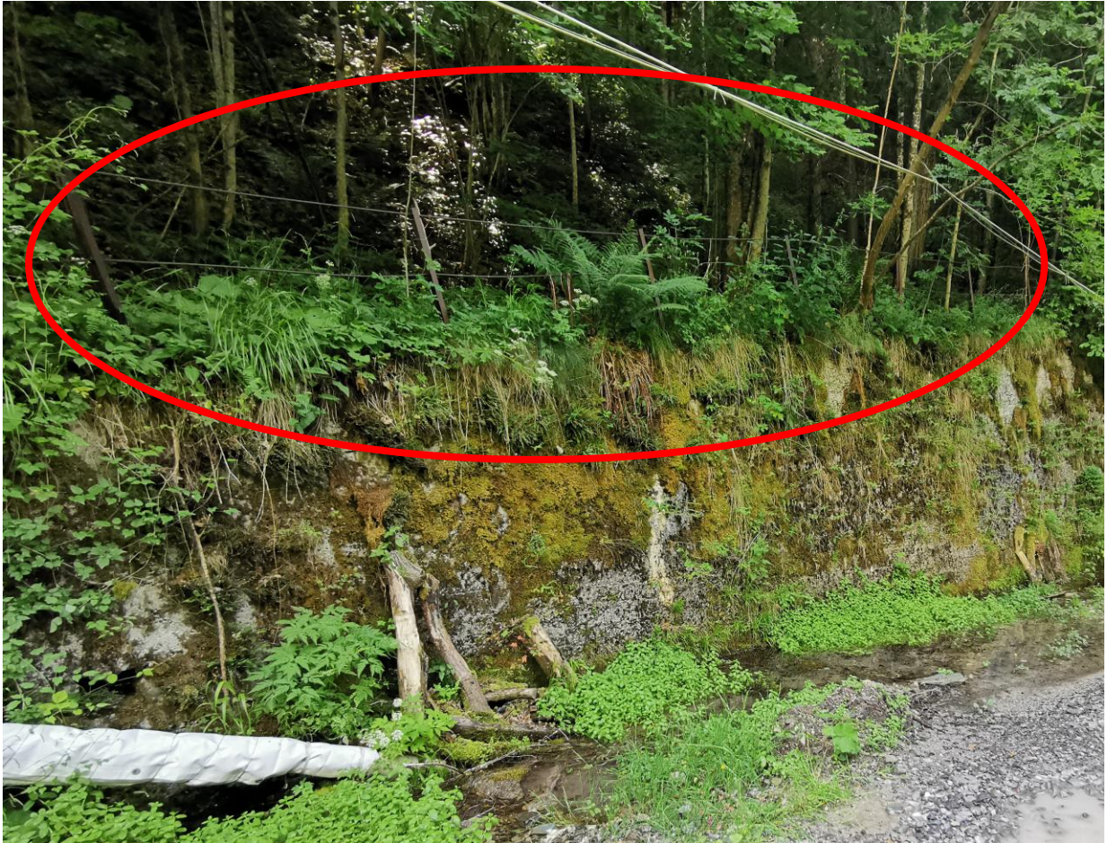
Fig. 17 Filo metallico sopra la strada in prossimità del n° 26 anfi
