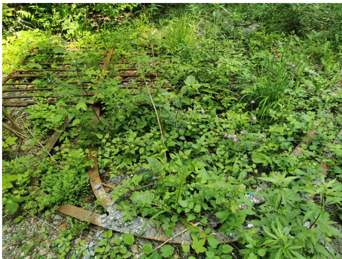
Fig. 20 vecchio cancello di entrata ormai coperto dalla vegetazione (2021)
