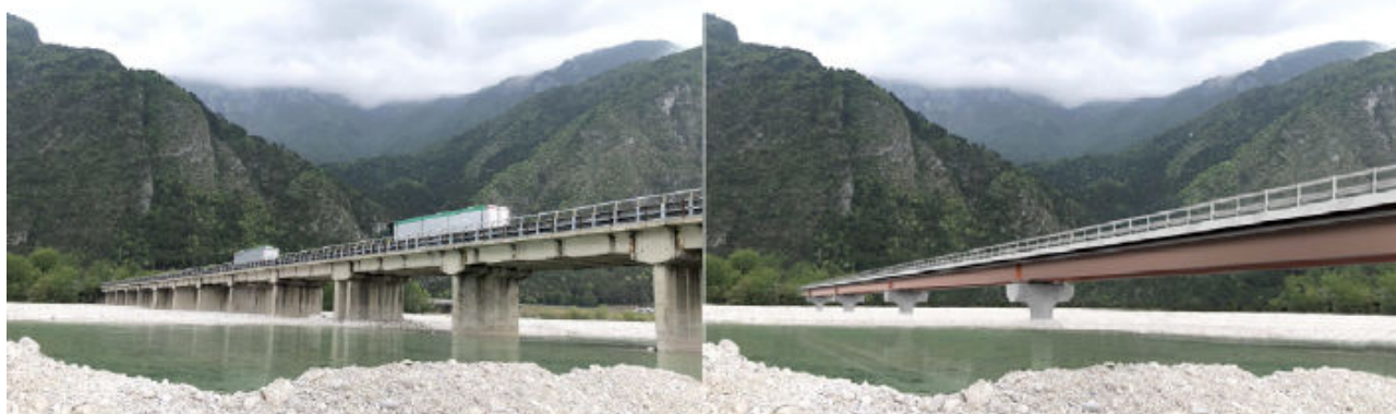
Fig. 3 Impalcato e sottostrutture Fonte: Relazione illustrativa e tecnica
