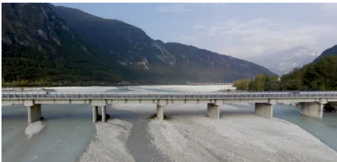
Fig. 2 Ponte sul Fiume Fella. Fonte: Relazione geologica ed indagini geognostiche
