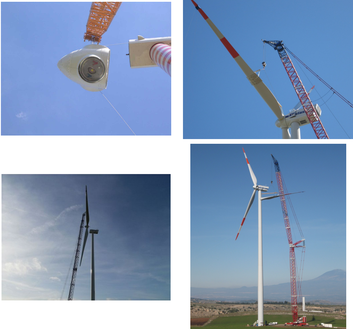
Figura 23: fasi di montaggio aerogeneratori
