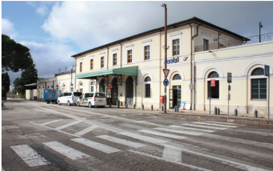
Figura 9 – Fabbricato viaggiatori esistente
