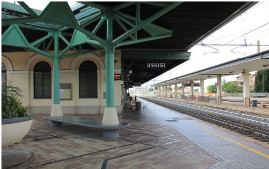
Figura 10 – Pensiline primo marciapiede
