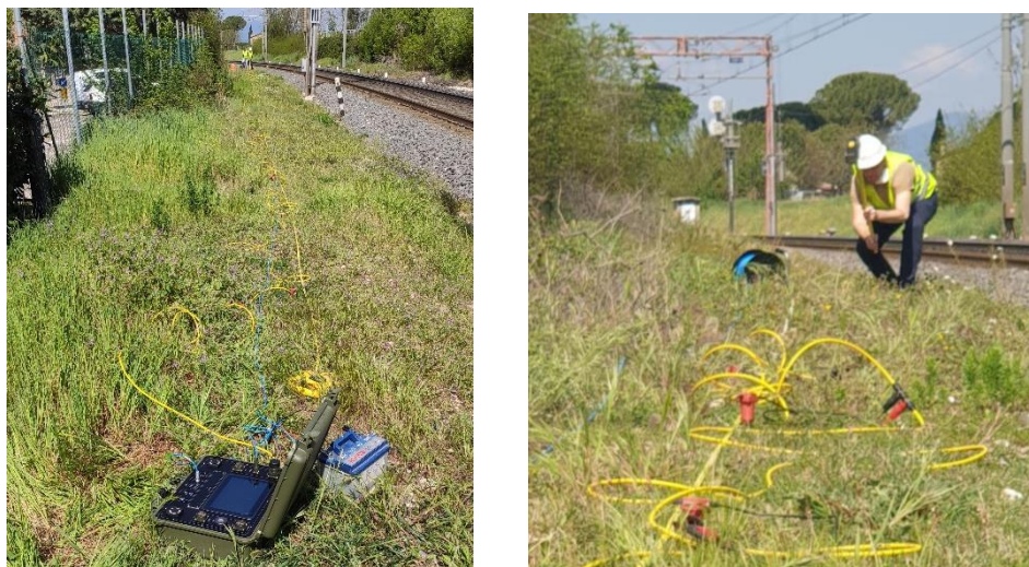
Figura 11 - Esecuzione delle indagini MASW
