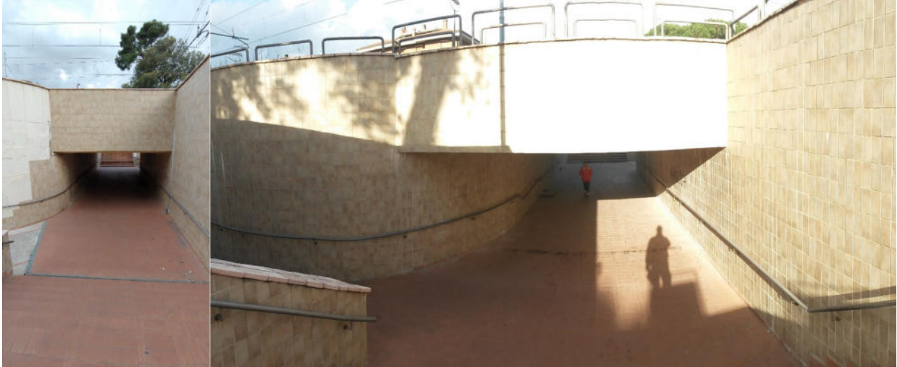
Figura 2: foto sottopasso al km 15+853
