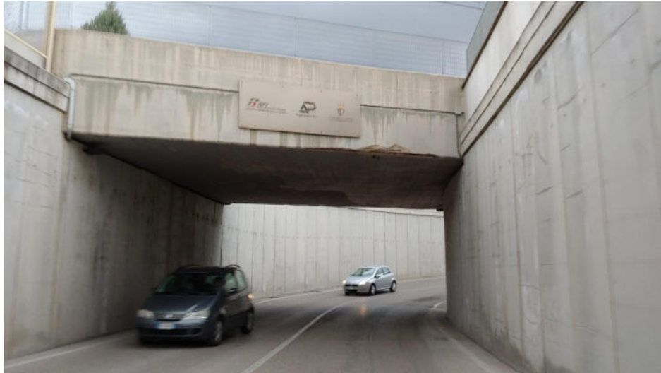
Figura 6: foto sottovia km 15+945
