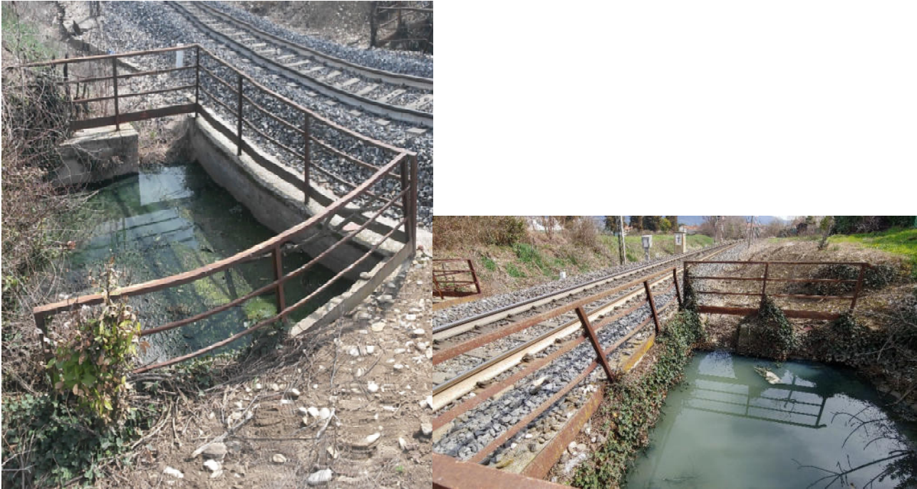
Figura 2: foto sifone km 16+239 dal rilievo
