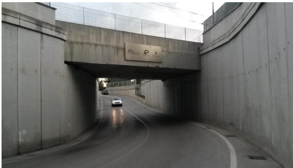
Figura 7: foto sottovia sottovia km 15+945
