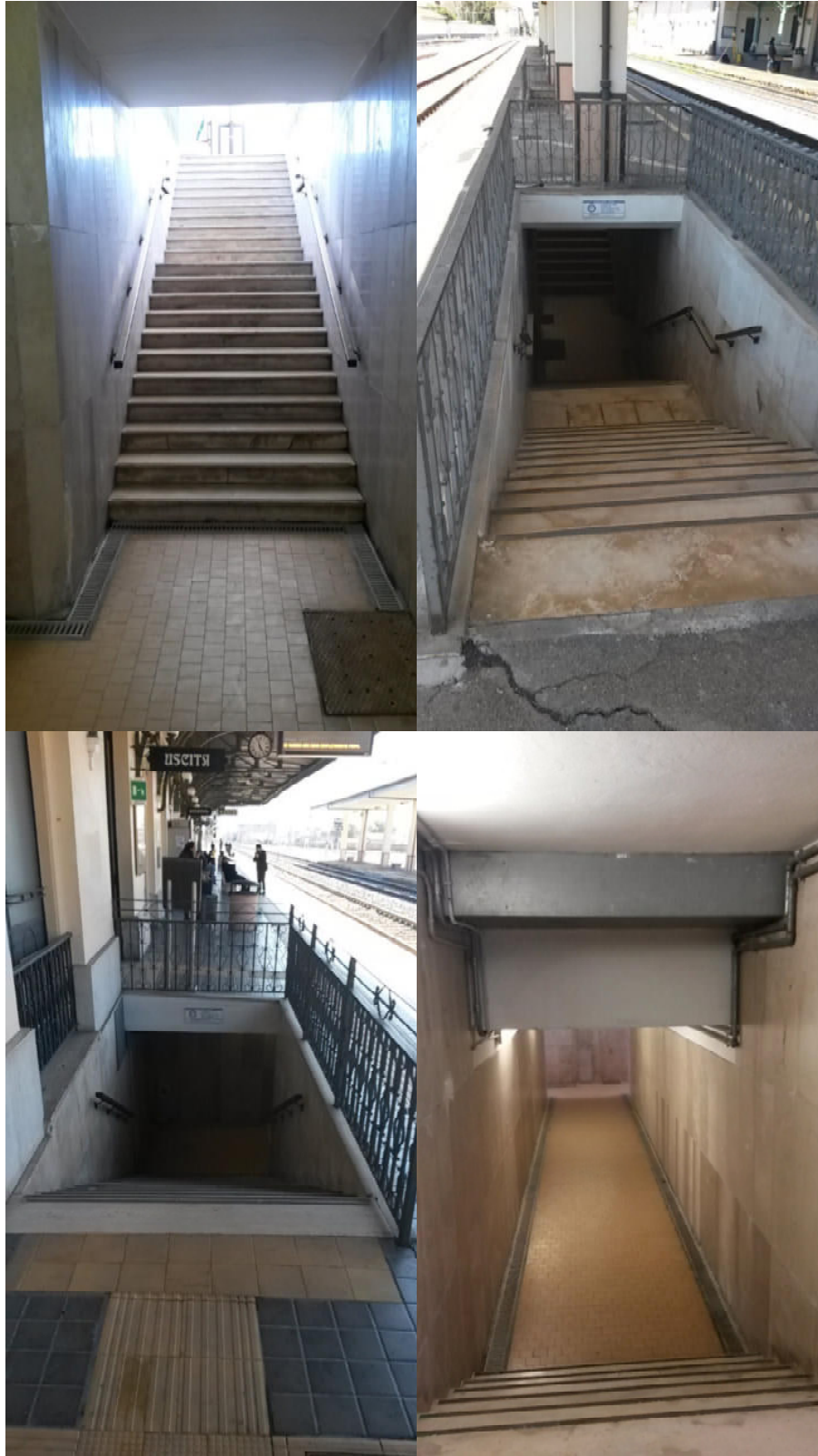
Figura 2: foto del sottopasso al km 15+635
