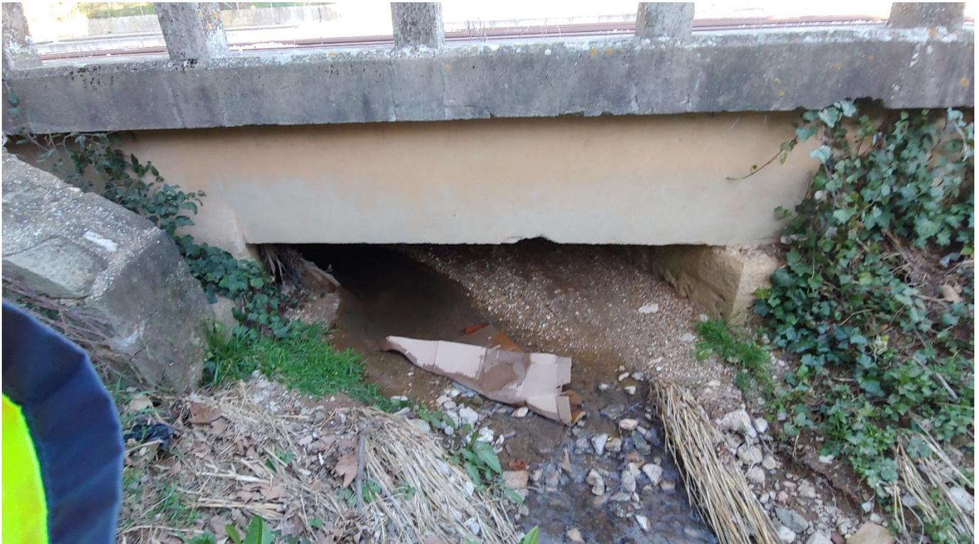
Come descritto nell'elaborato IR0B02D10RHIN0200001A si prevede la dismissione dell'opera e la sostituzione con un'opera idraulicamente adeguata ubicata in stretto affiancamento.
