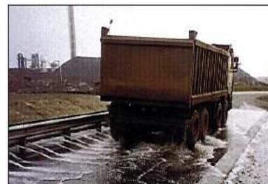
*Figura 4-7: Canali di lavaggio in controcorrente*
