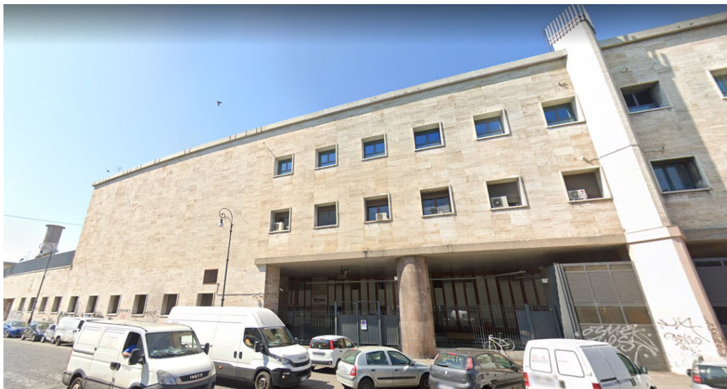
Figura 6 – Fabbricato Posto Centrale di Roma Termini
