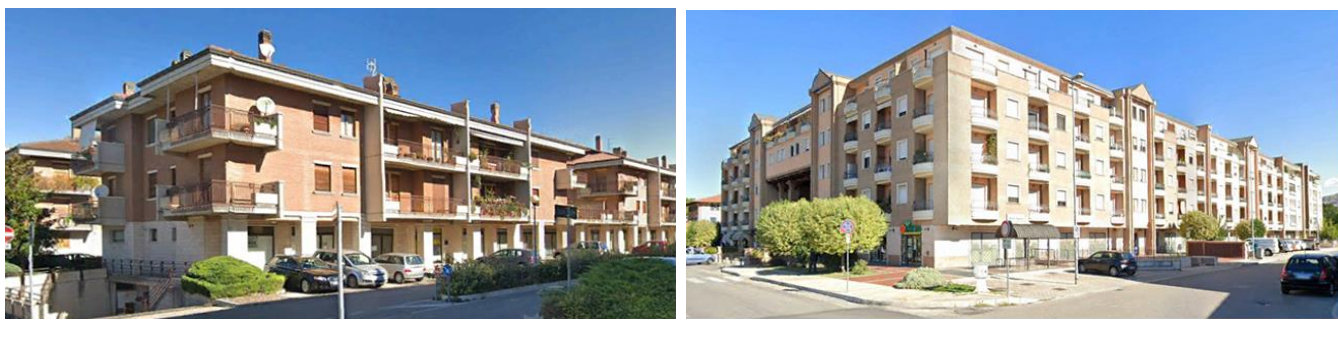
Figura 2-26 Tipologia edilizia presente lungo la linea ferroviaria oggetto di analisi (Fonte: Viale Patrono d'Italia ; Via Antonio Fogazzaro )
