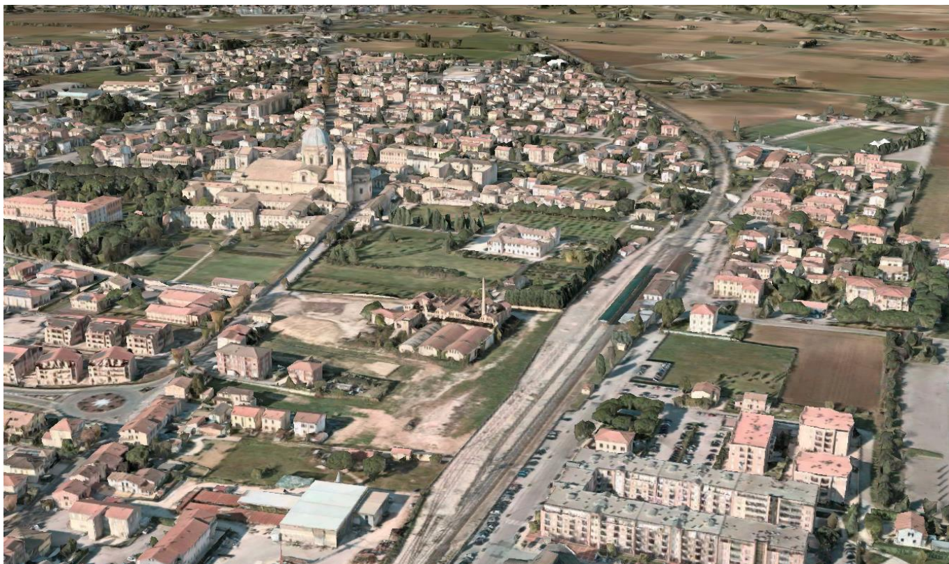
Figura 2-25 Tessuto residenziale presente in prossimità della linea ferroviaria interessata dall'intervento.
