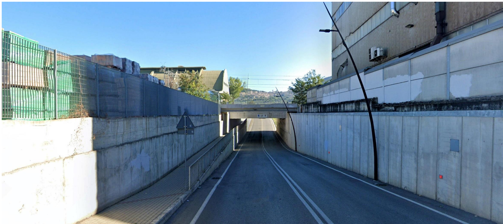
Punto di vista n.10 – Visuale frontale da Via Francesco di Bartolo verso l'infrastruttura ferroviaria, debolmente filtrata da elementi di recinzione.
