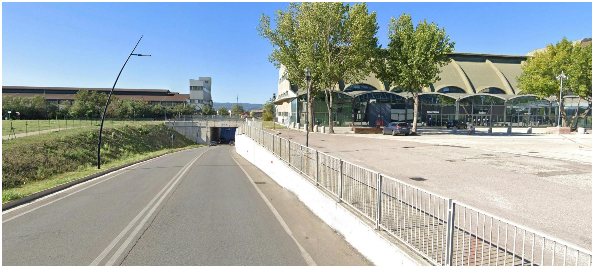
Punto di vista n.2 – Visuale frontale da Via delle Valecchie verso l'infrastruttura ferroviaria.
