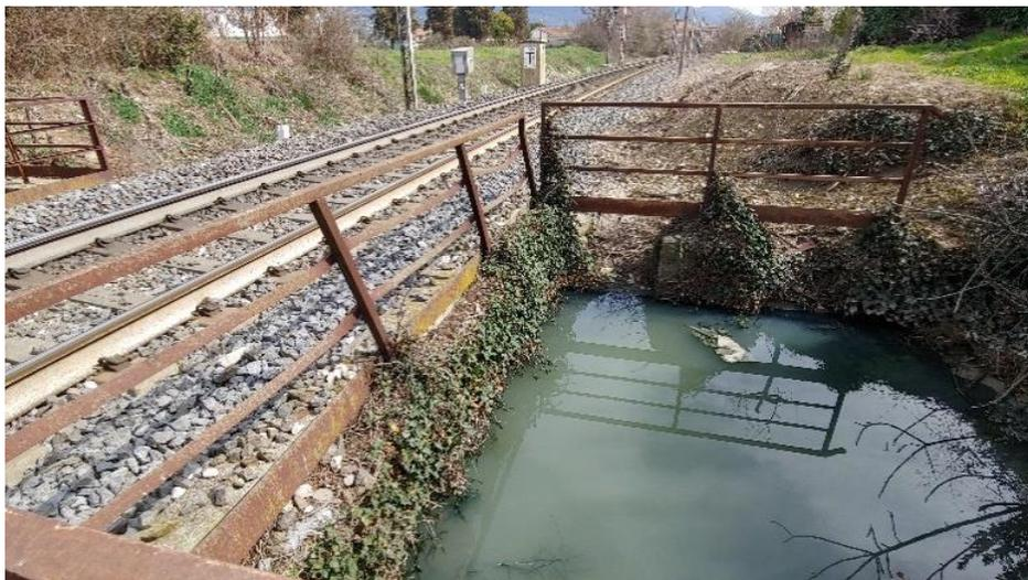
*Figura 2-5 Opere idrauliche nella stazione di Assisi: foto sifone km 16+239*
