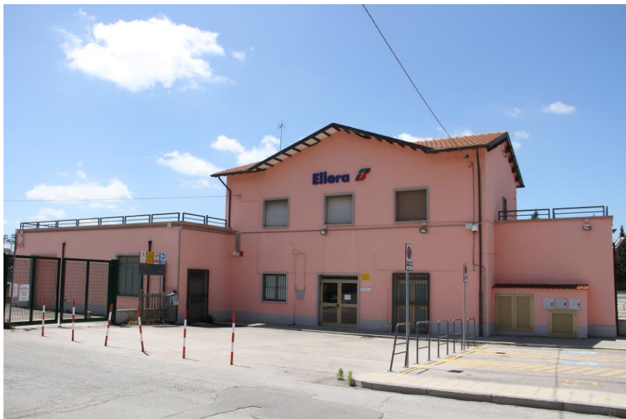
Figura 2 – Fabbricato viaggiatori e parcheggio esistenti
