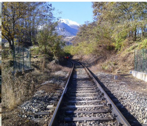
Impianto lubrificazione P.A.L. Italia (Foto: P.A.L. Italia; 2012)
