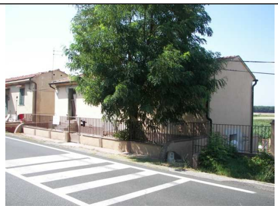
Ricettore PI10 su SS67 Via Arnaccio (in ristrutturazione)
