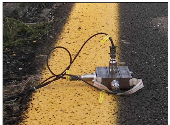
Figura 2.7-3 Massetto metallico con terna di accelerometri
