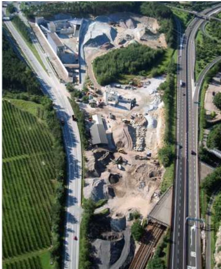
Figura 3-6 Impianto Beton Eisack
