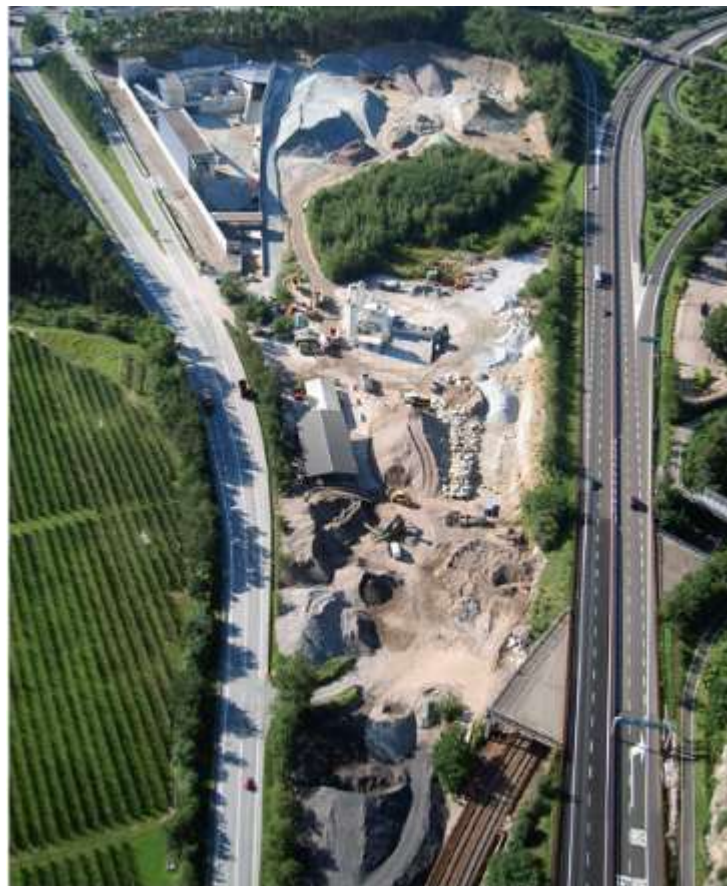
Figura 3-1 Impianto Beton Eisack
