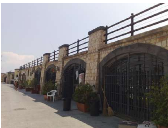
locali nella banchina del sopraflutto
