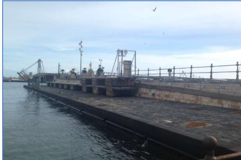
Figura 5- Molo di sottoflutto: paramento esterno è costituito da una struttura a parete verticale
