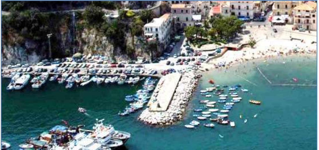
Figura 1- Preesistente sottoflutto con struttura esterna a gettata.
