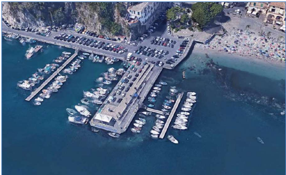
Figura 4- Attuale sottoflutto. Il paramento esterno è costituito da una struttura a parete verticale
